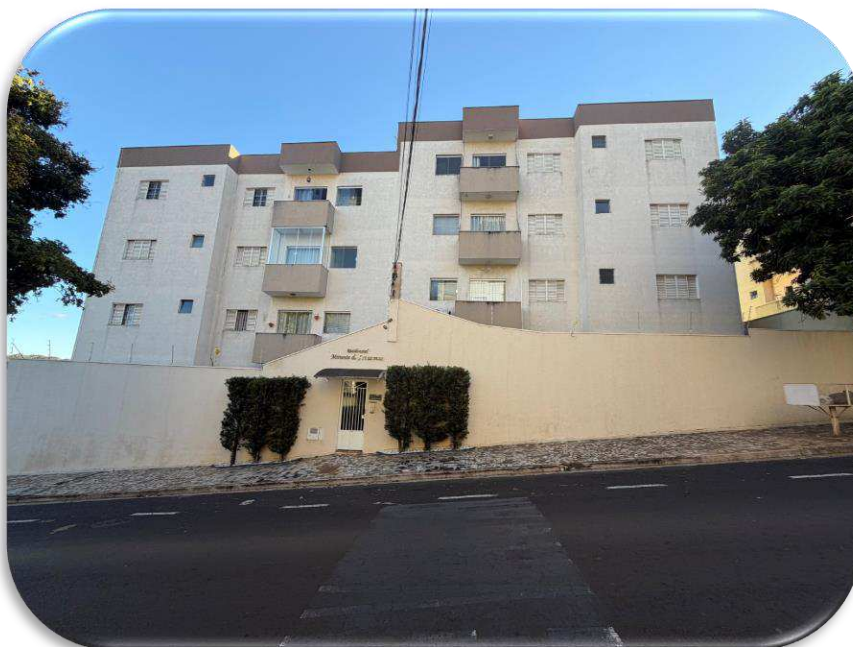
Vista do imóvel avaliando
