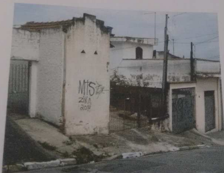
Foto nº. 4- Vista da Rua Hortelão do Mato à direita do imóvel
