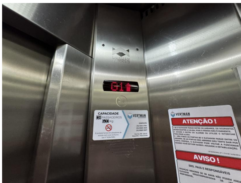
Imagem 12 - Vista do elevador do condomínio.
