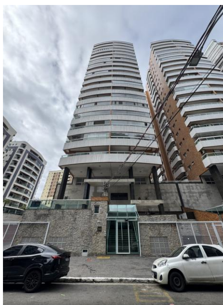
Imagem 04 - Vista geral da fachada do Condomínio Edifício Ilha de Santorini.
