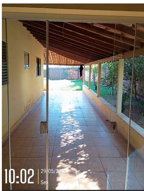
Varanda que cerca a edificação.
