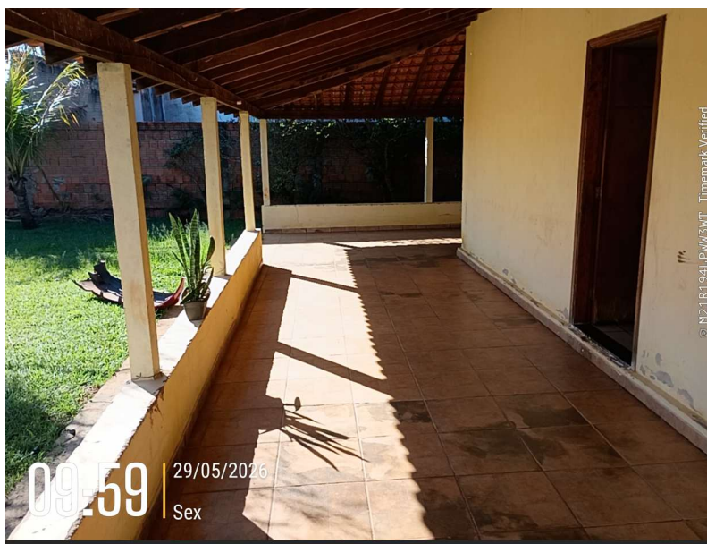
Edificação cercada por varanda em toda sua extensão.
