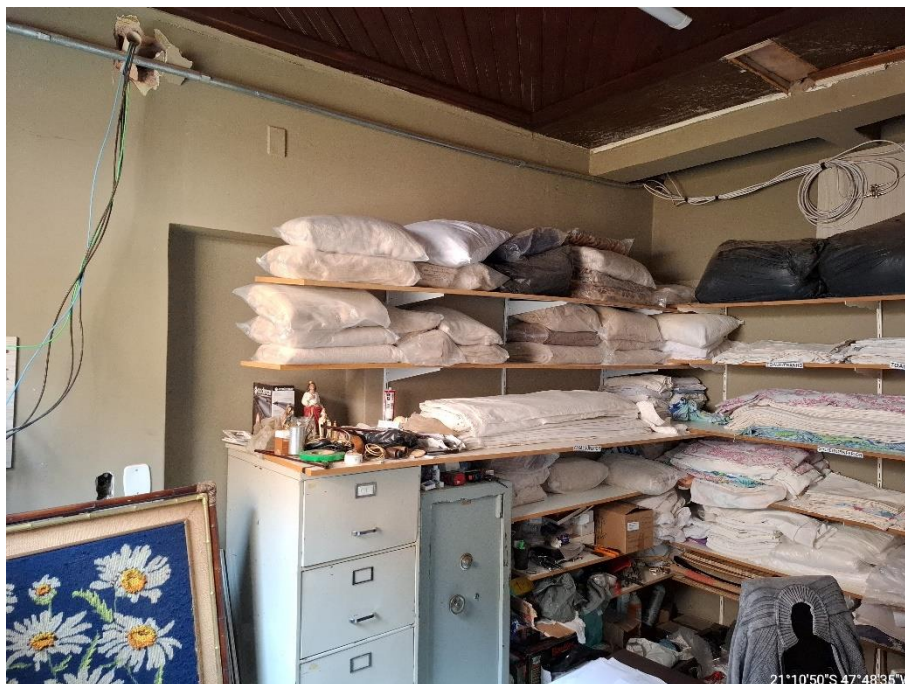
Foto 9 - Outra vista do ambiente, utilizado para depósito
