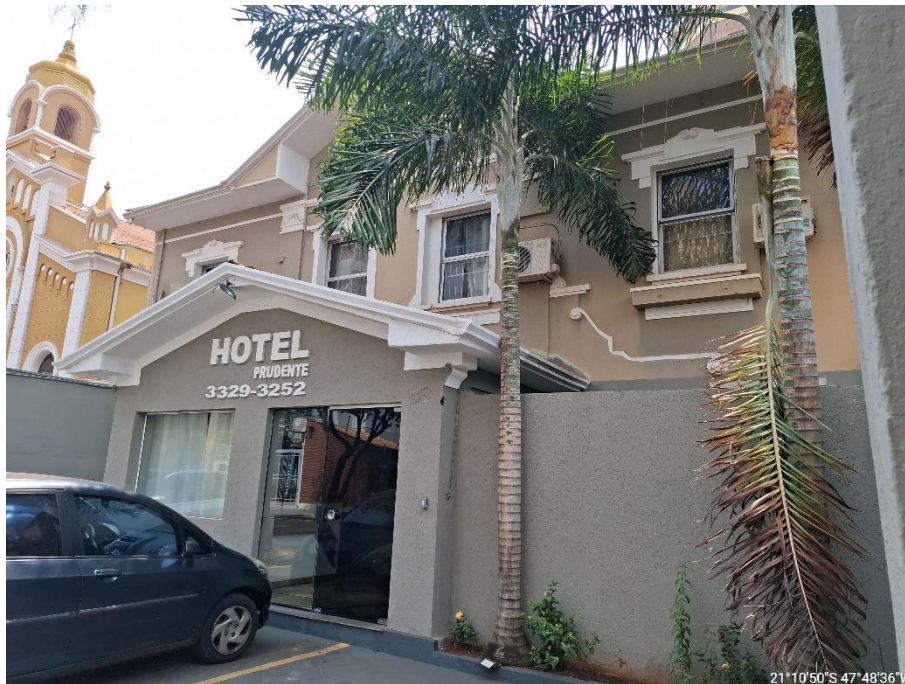
Foto 5 - Outra vista da fachada do imóvel
