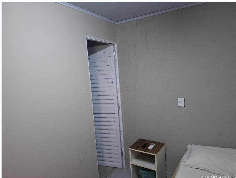
Foto 12 - Vista parcial do dormitório
