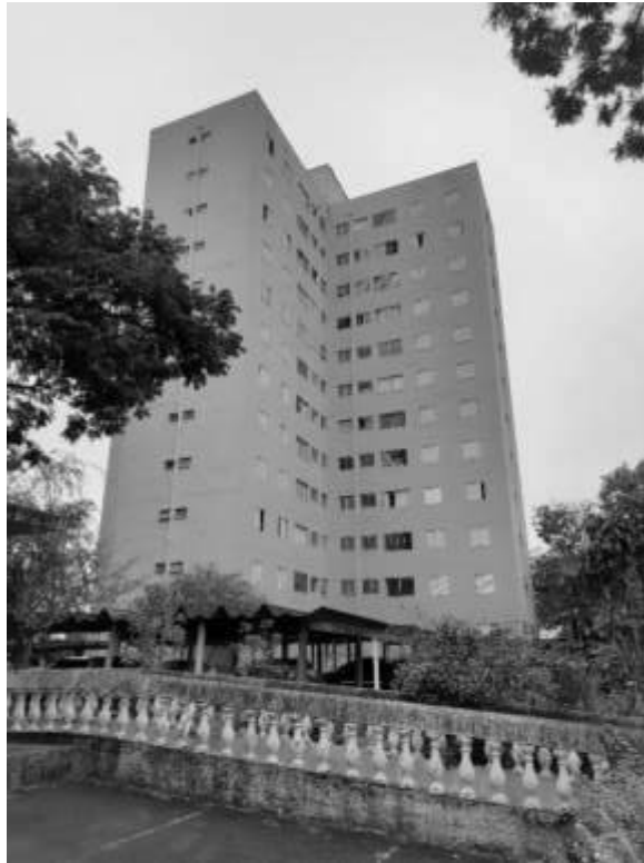
Foto 1 - Fachada do Imóvel
