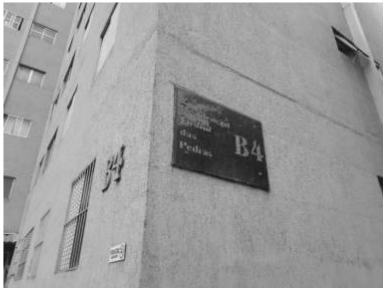
Foto 2 - Entrada do Imóvel
