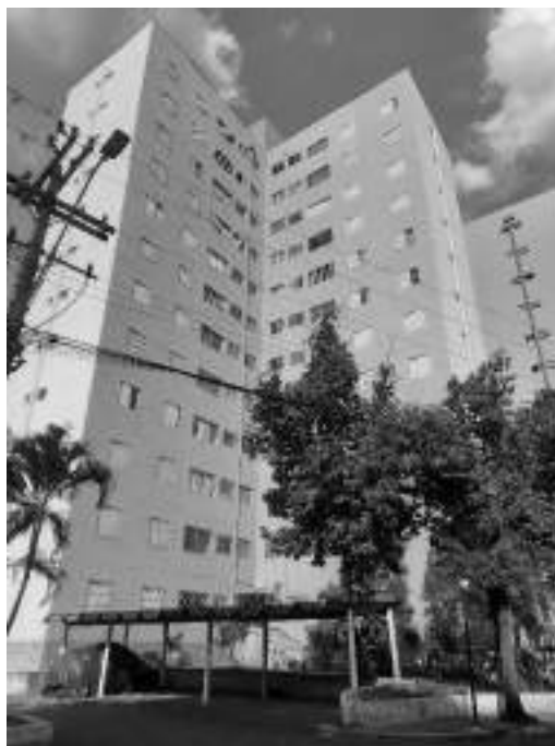
Foto 1 - Fachada do Imóvel
