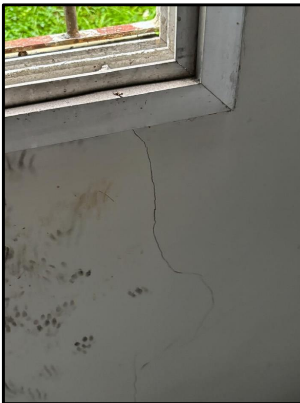
Foto 35: Trinca parede
