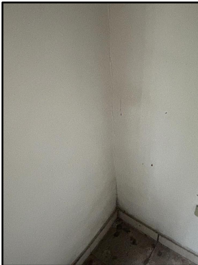
Foto 35: Trinca parede
