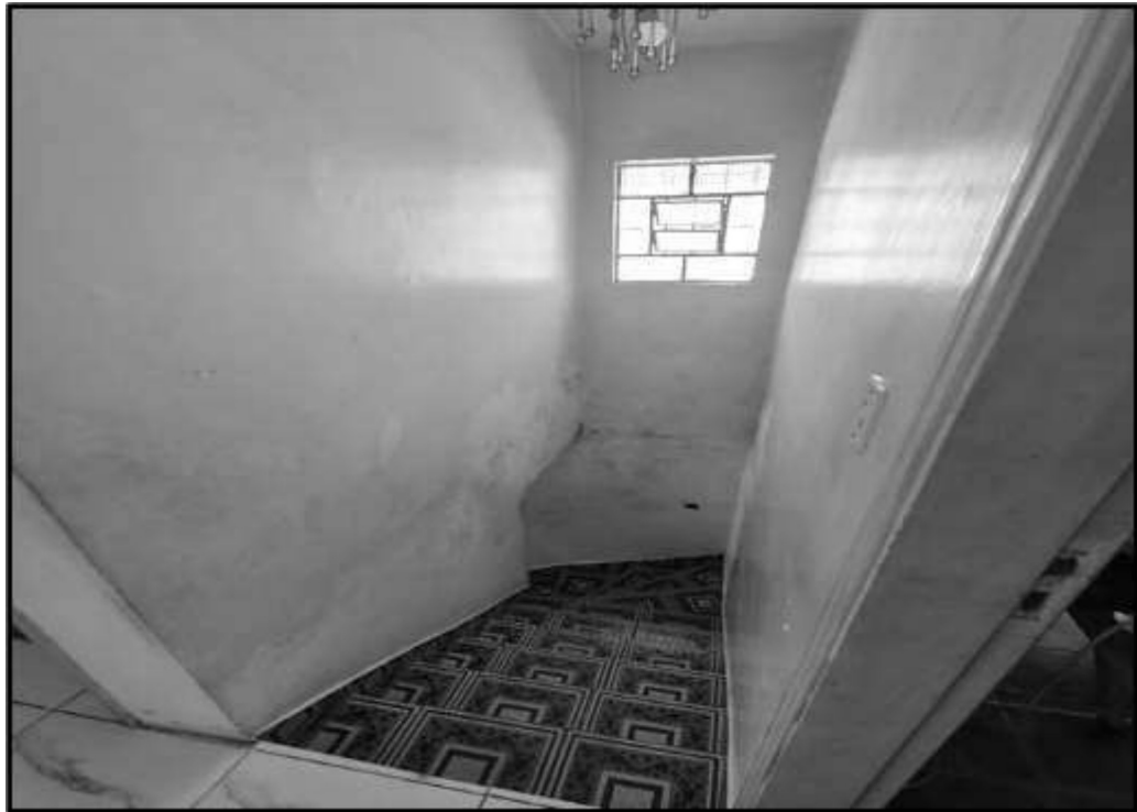
Fotos 21 – Vista da escada acesso ao pavimento inferior.
