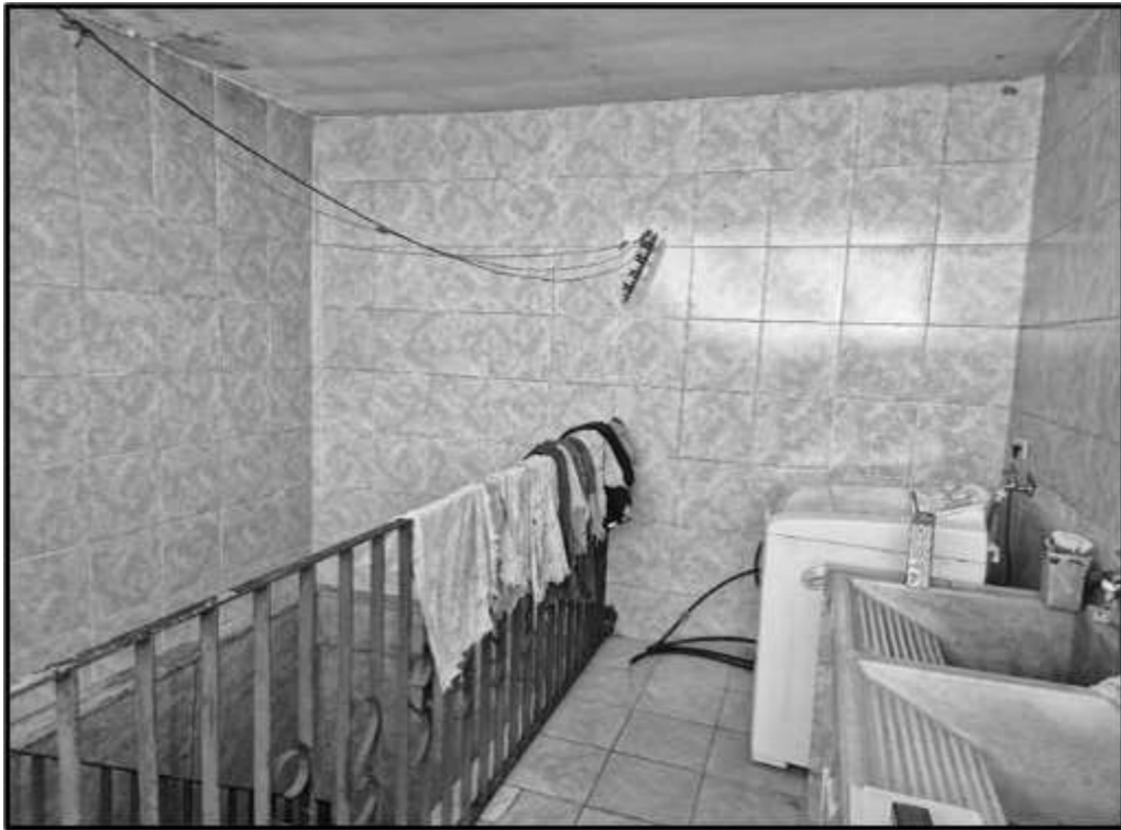
Fotos 13 – Área de Serviço.
