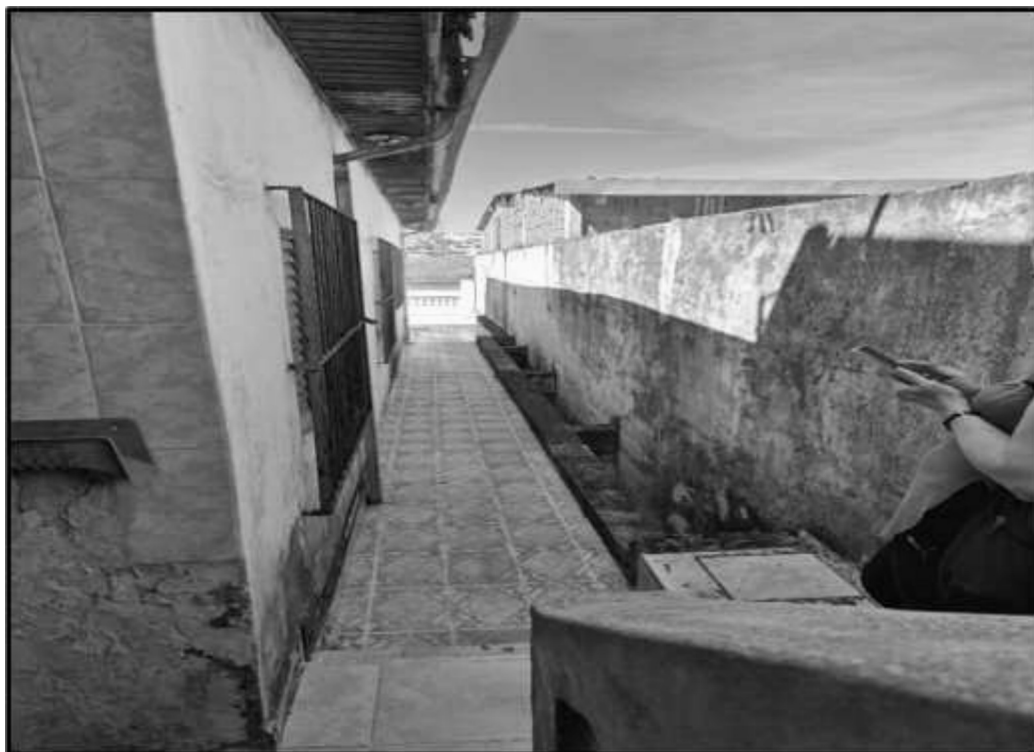
Fotos 16 – Corredor lateral – pavimento superior.
