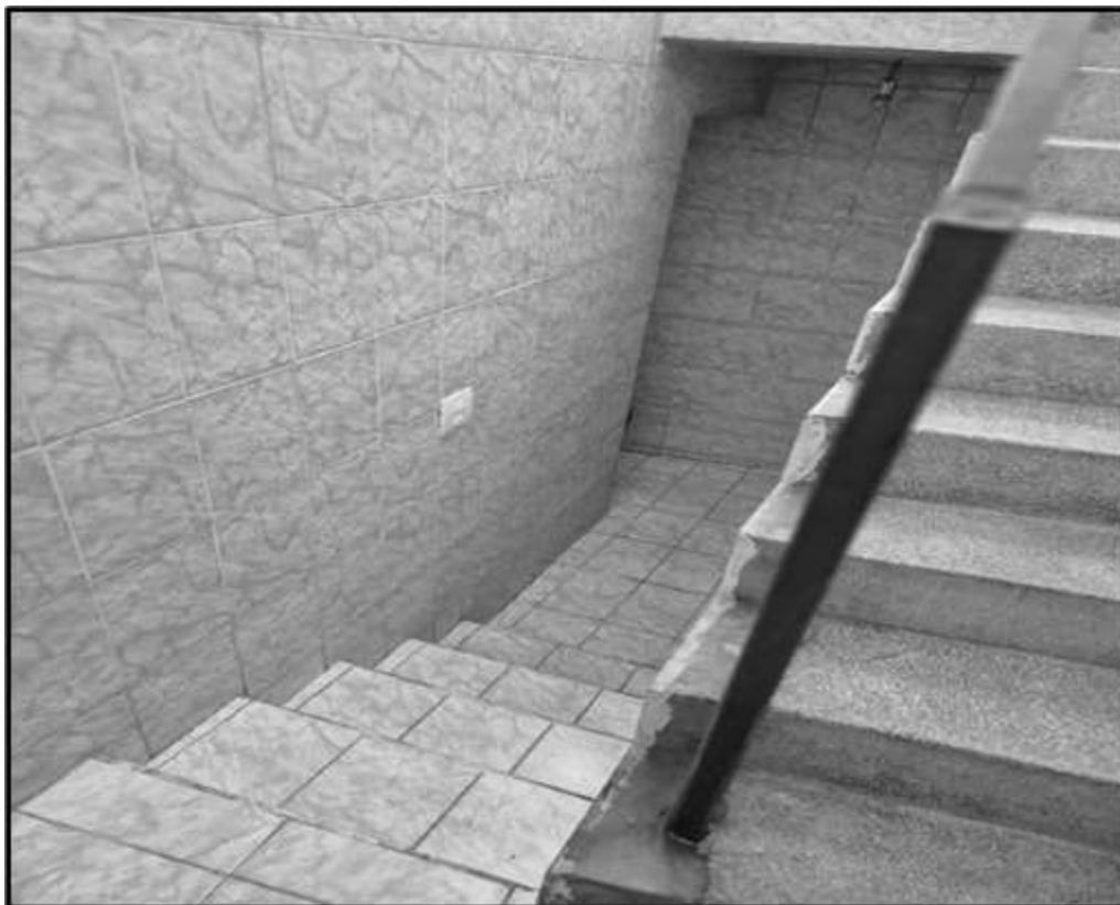
Fotos 12 – Escada acesso à área se serviço.
