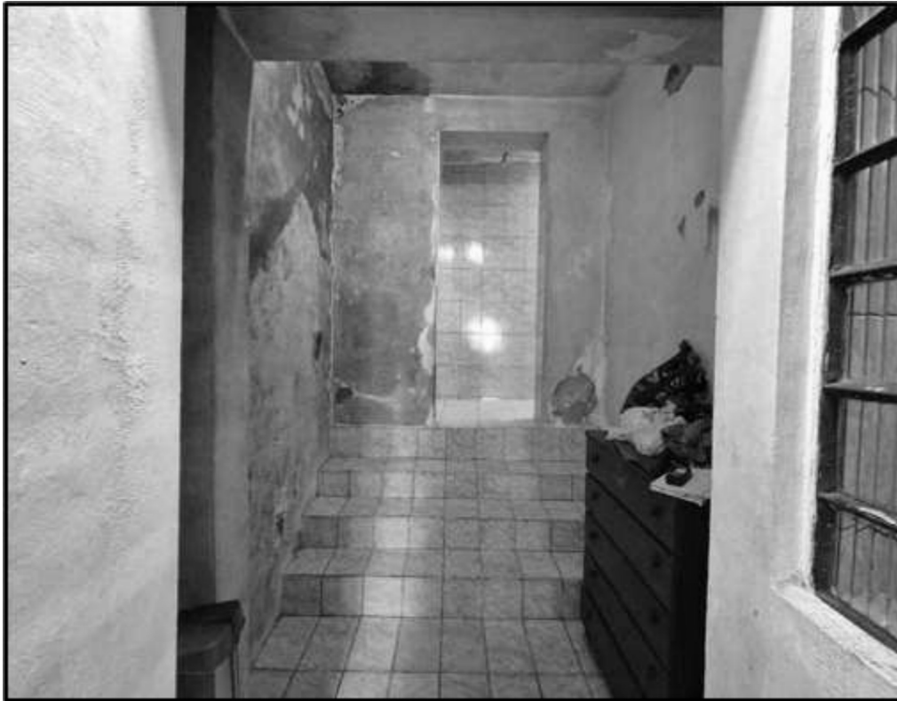
Fotos 11 – Corredor lateral direção ao fundo do imóvel.
