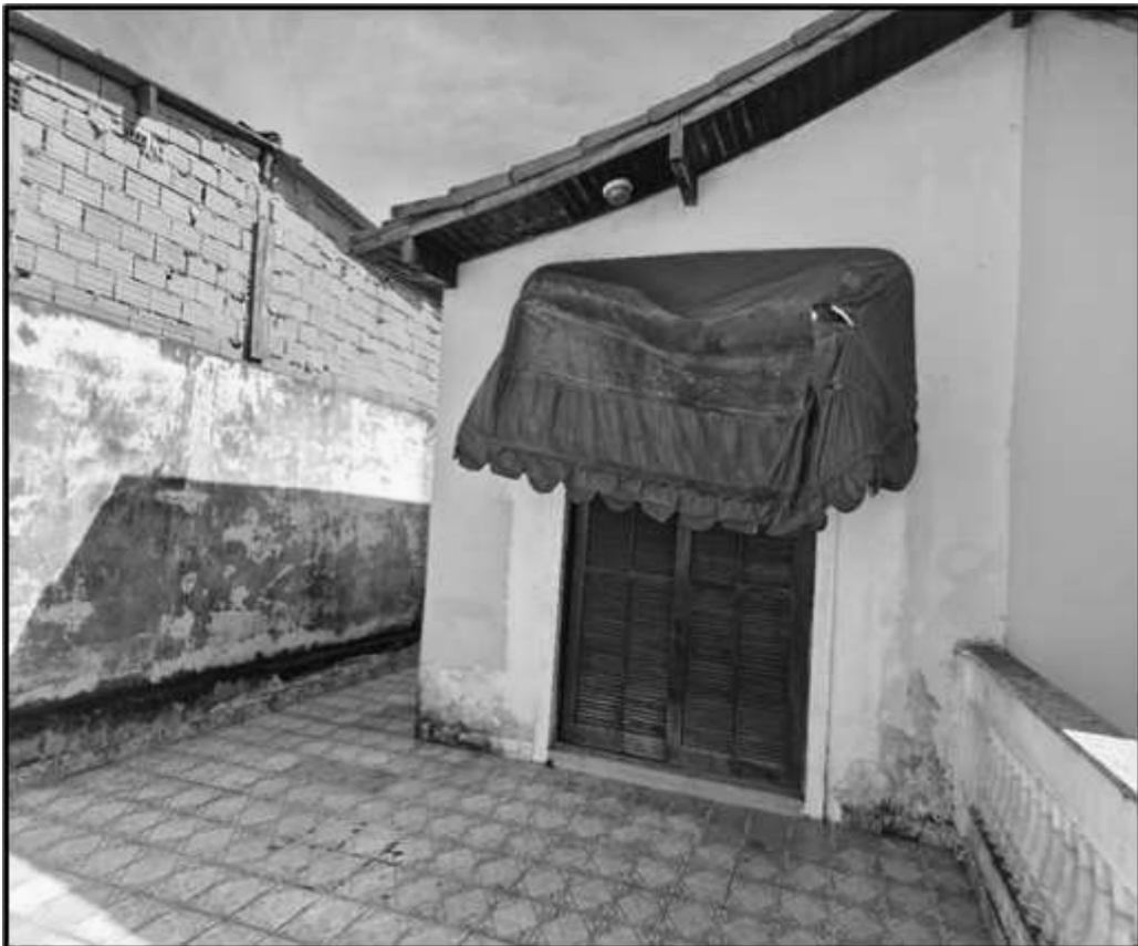
Fotos 18 – Cobertura frontal – vista do porta balcão de acesso ao dormitório 1.
