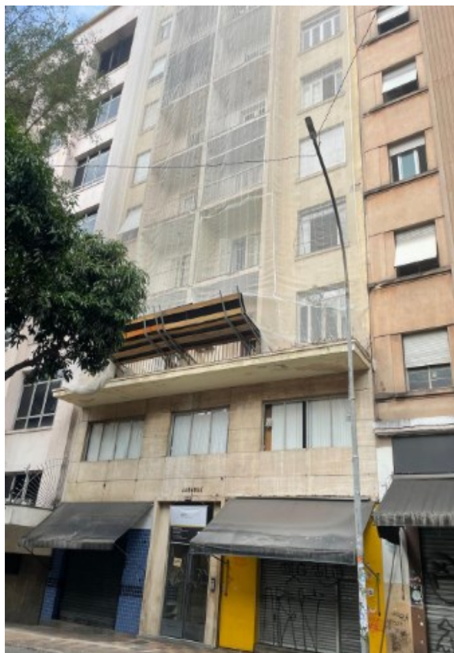
FOTO 01 Vista parcial Fachada condomínio Jaraguá
