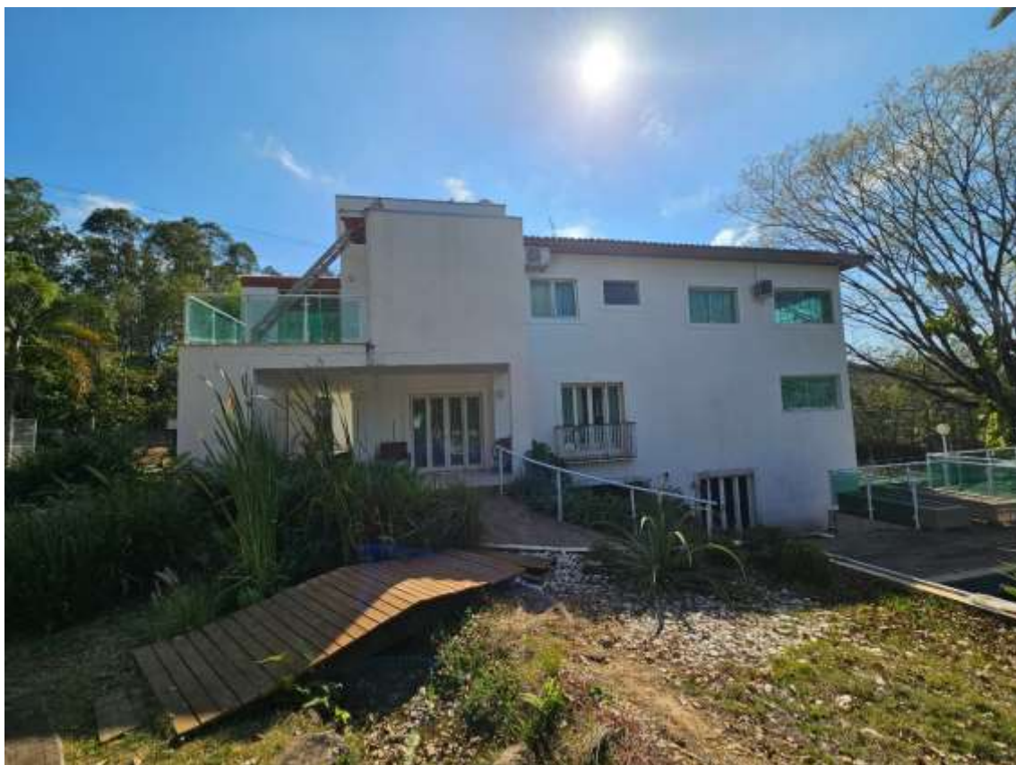
26 – Fachada Lateral Direita
