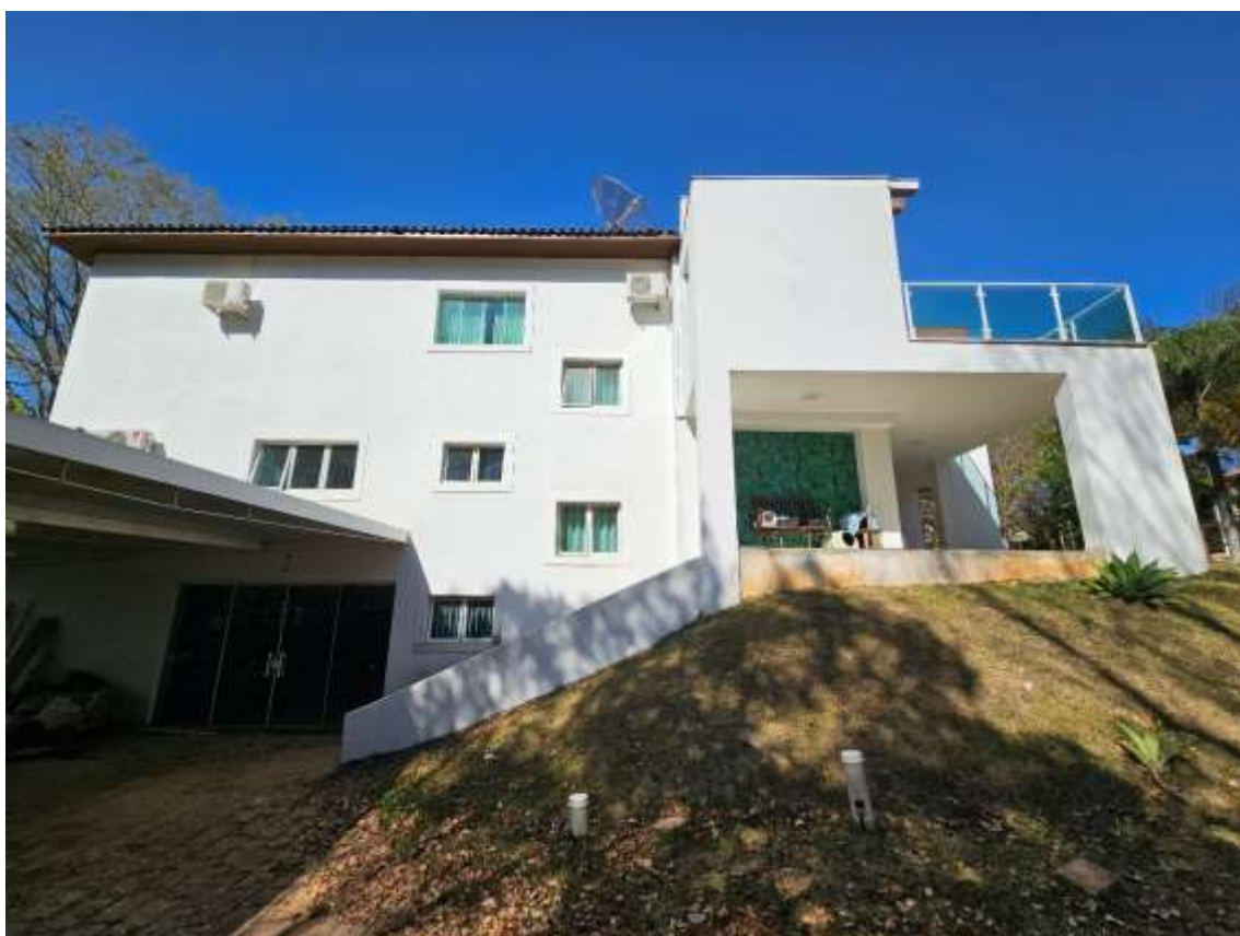
28 – Fachada Lateral Esquerda
