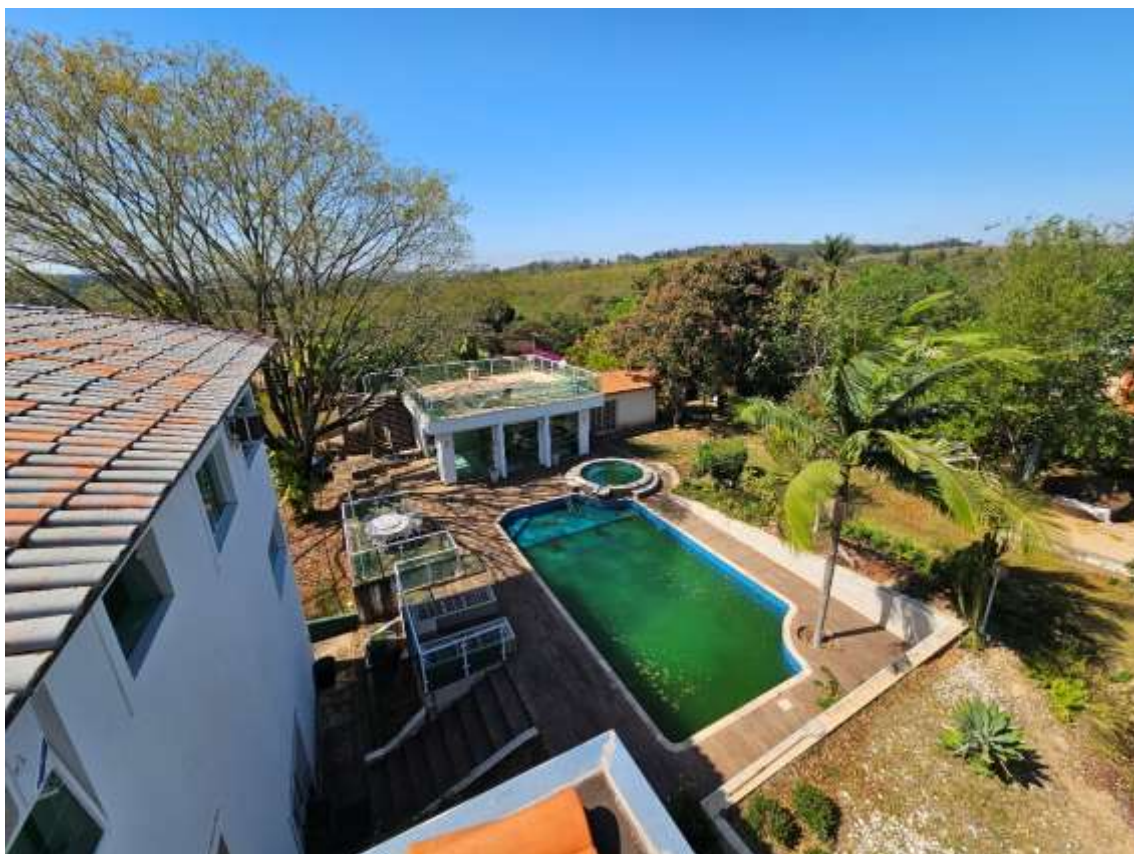
49 – Vista geral da área externa
