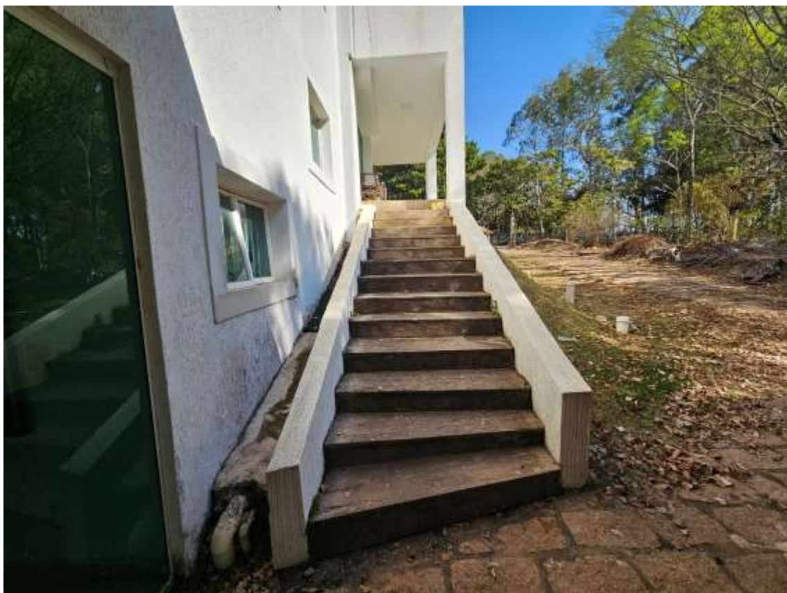
55 – Pavimento Inferior – Acesso externo para o Pavimento Térreo
