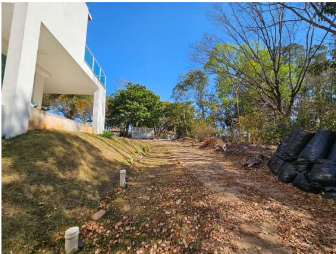
43 – Rampa de acesso da garagem para a rua
