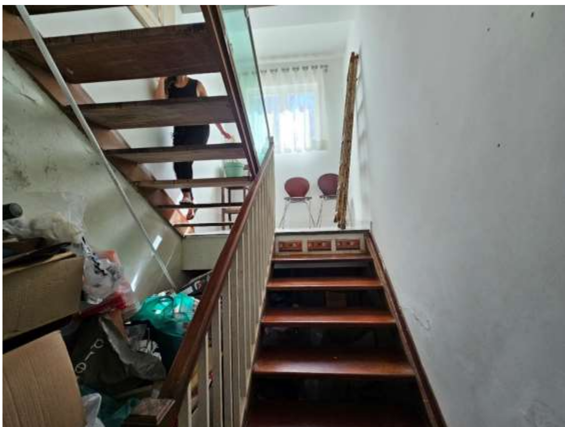
62 – Pavimento Inferior – Acesso ao Pavimento Térreo
