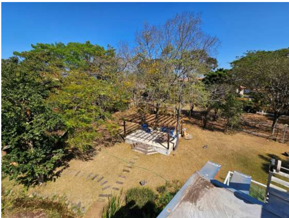
50 – Vista geral da área externa
