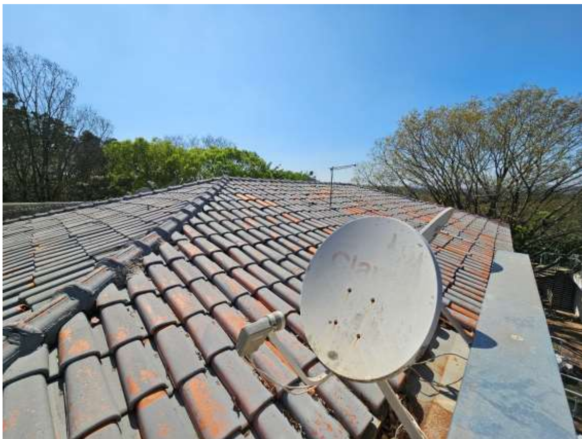
51 – Vista geral do telhado
