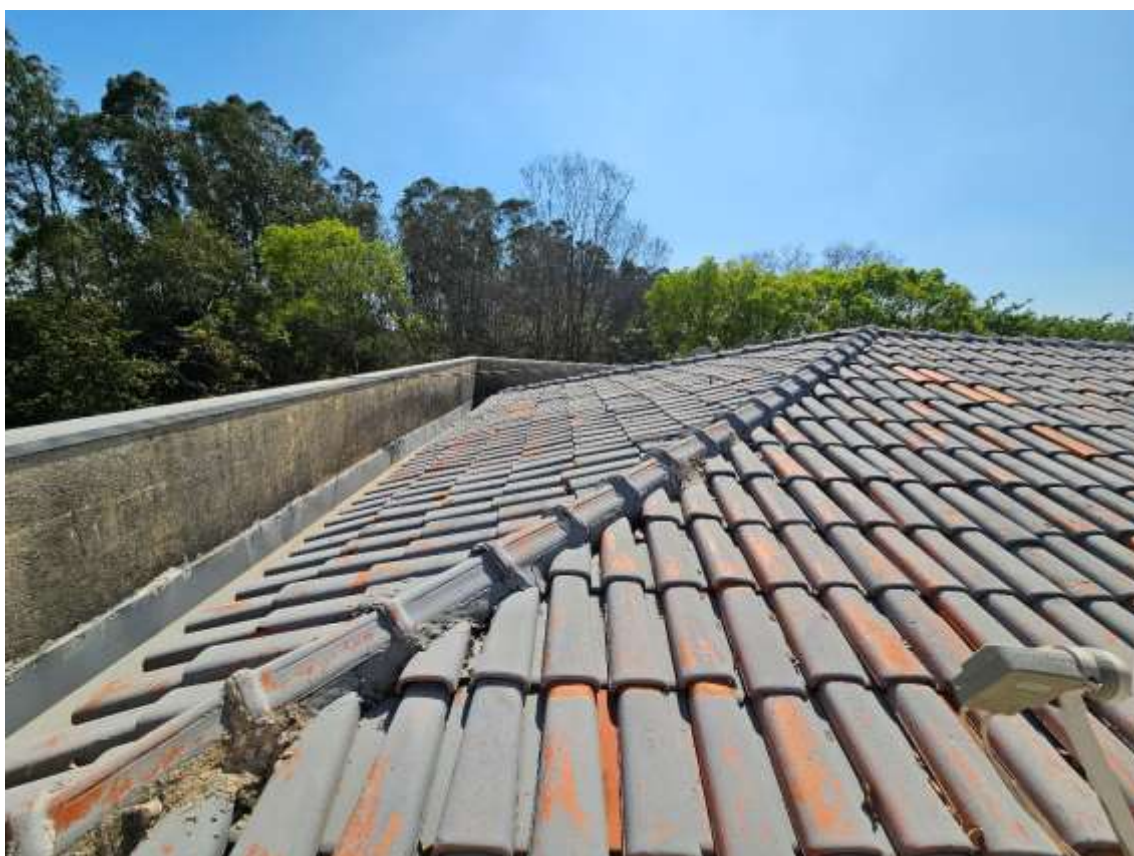
52 – Vista geral do telhado
