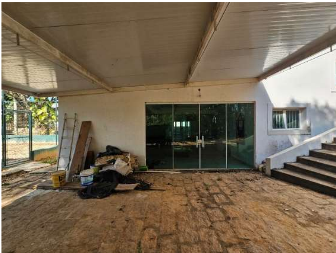
53 – Pavimento Inferior – Acesso externo via garagem
