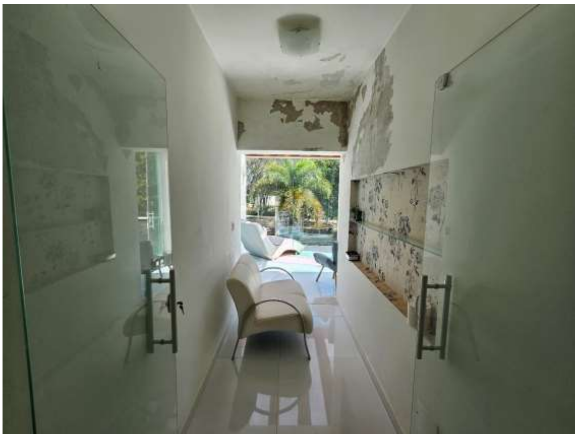
91 – Pavimento Superior – Acesso a área de luz
