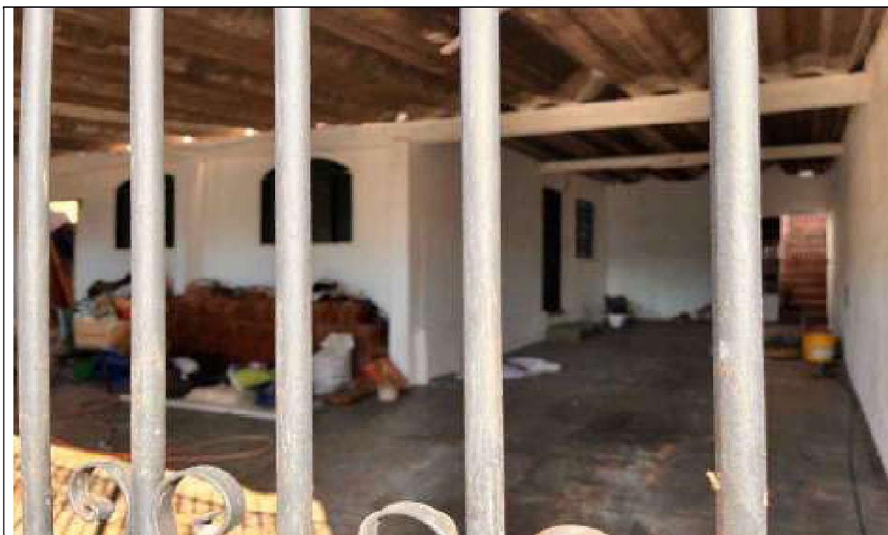
Foto 4: Vista da frente e garagem do imóvel avaliado.
