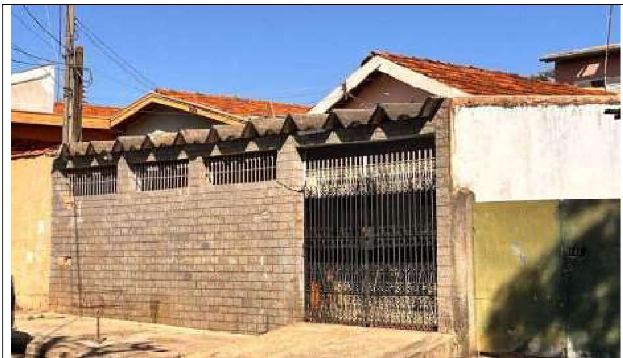
Foto 3: Vista da frente e garagem do imóvel avaliado.
