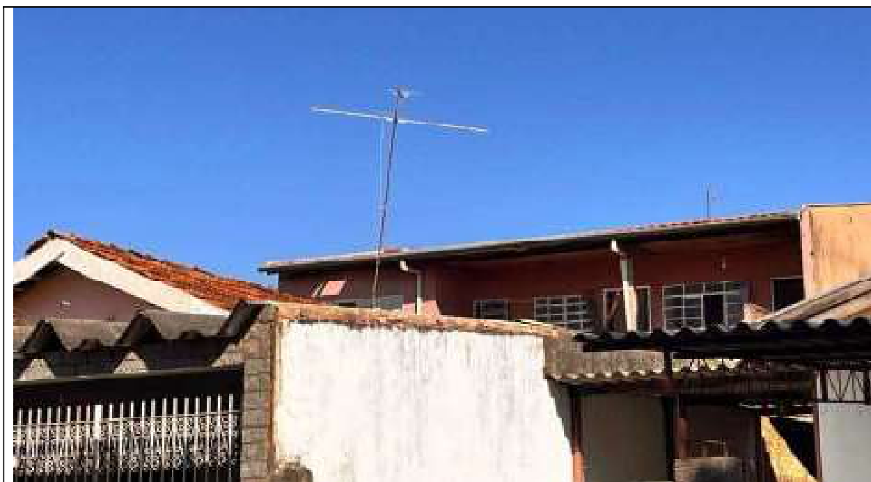
Foto 2: Vista do imóvel, onde se observa a edícula assobradada nos fundos do lote.
