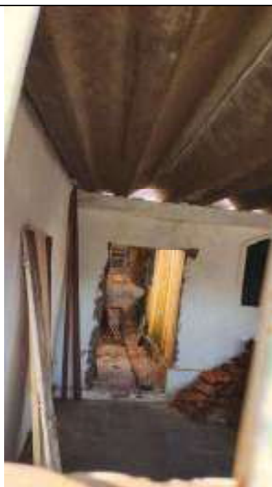
Foto 6: Vista do corredor lateral esquerda do imóvel.
