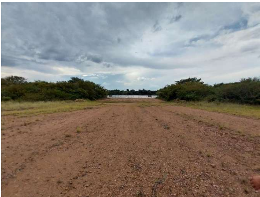
Vista Geral da Pavimentação do Cais
