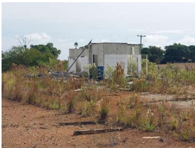
Vista Geral da Edificação (praticamente inteiro demolido)
