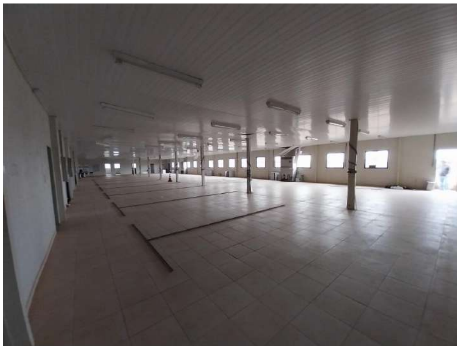
CLIMATIZADORES SALA DA ENGENHARIA - TRÊS UNIDADES
