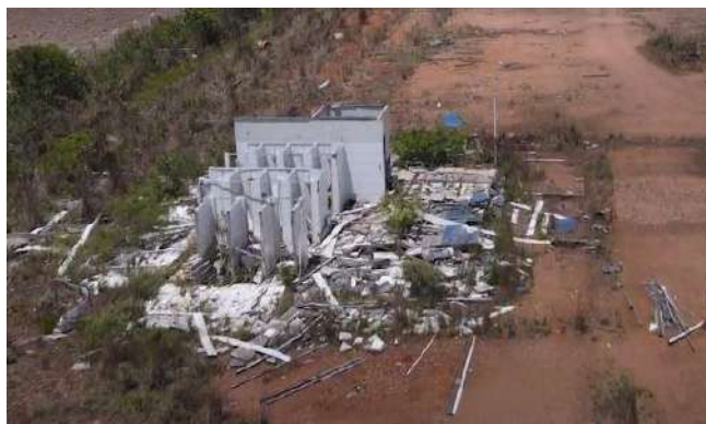
Vista Geral Edificação (praticamente inteiro demolido)
