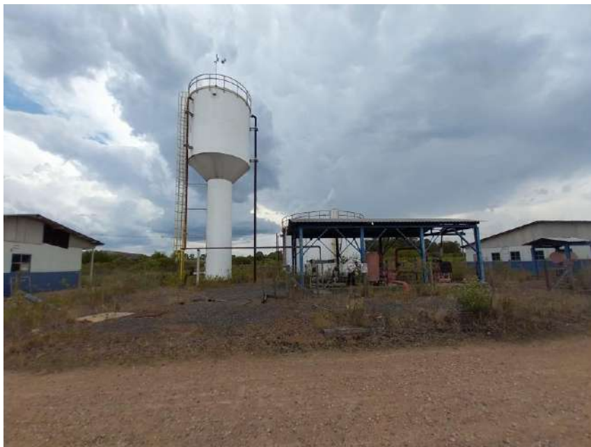
Vista do Castelo D'água (15m 3 ) e Reservatório de 25m 3
