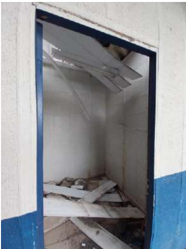
Vista Interna da Edificação (forro e cobertura danificados)
