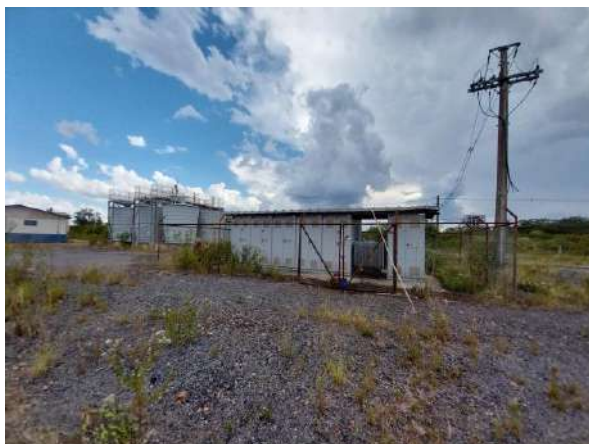
Vista Geral da Edificação
