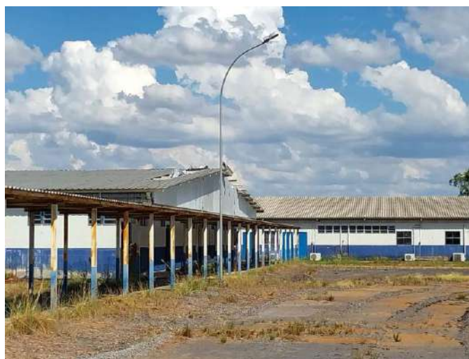
Vista Geral da Edificação
