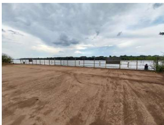
Vistas contendo pavimentações do Cais
