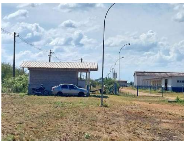
Vista Geral da Edificação
