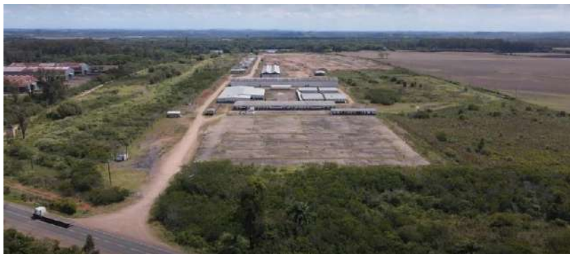
RODOVIA RS 401 – Km 28, no. 2301 Granja Carola Zona Industrial Municipal de Charqueadas
