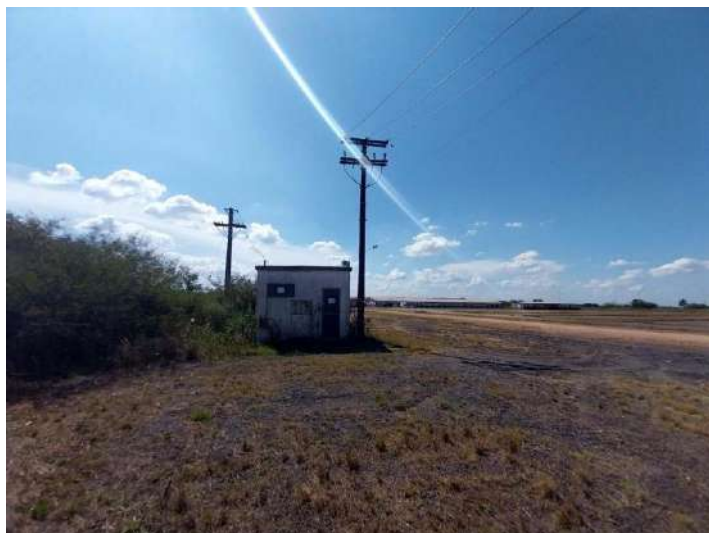
Vista Geral da Edificação
