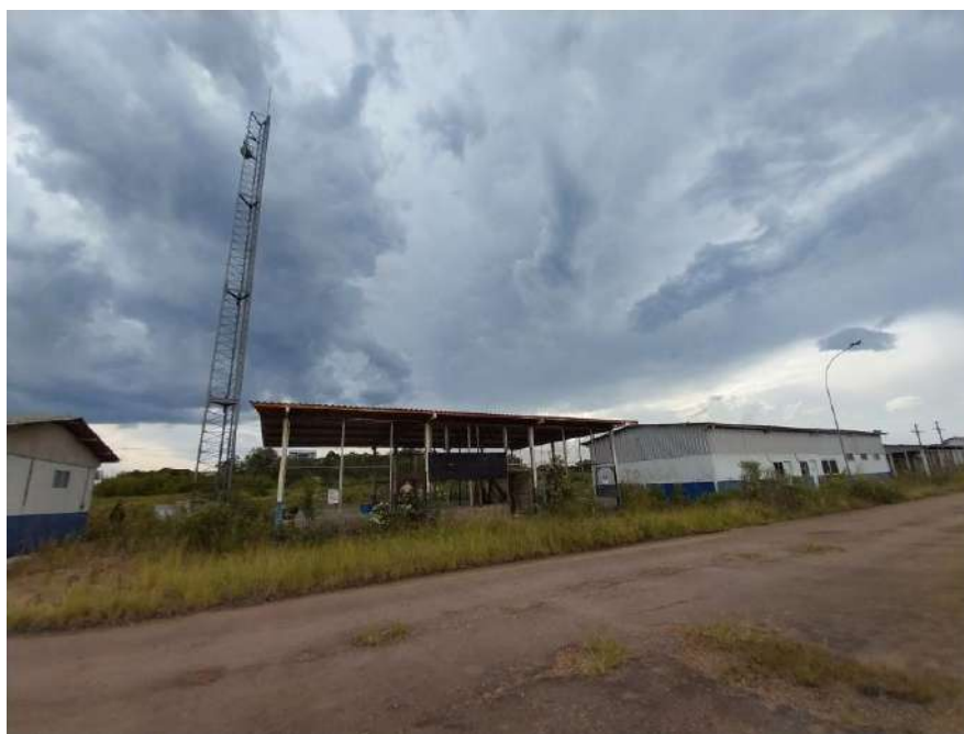
Vista Geral da Edificação
