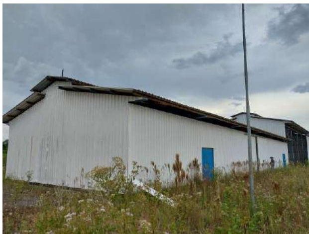
Vista Geral da Edificação
