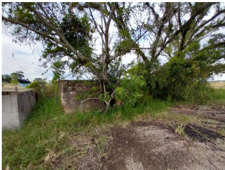
Vista Geral da Edificação
