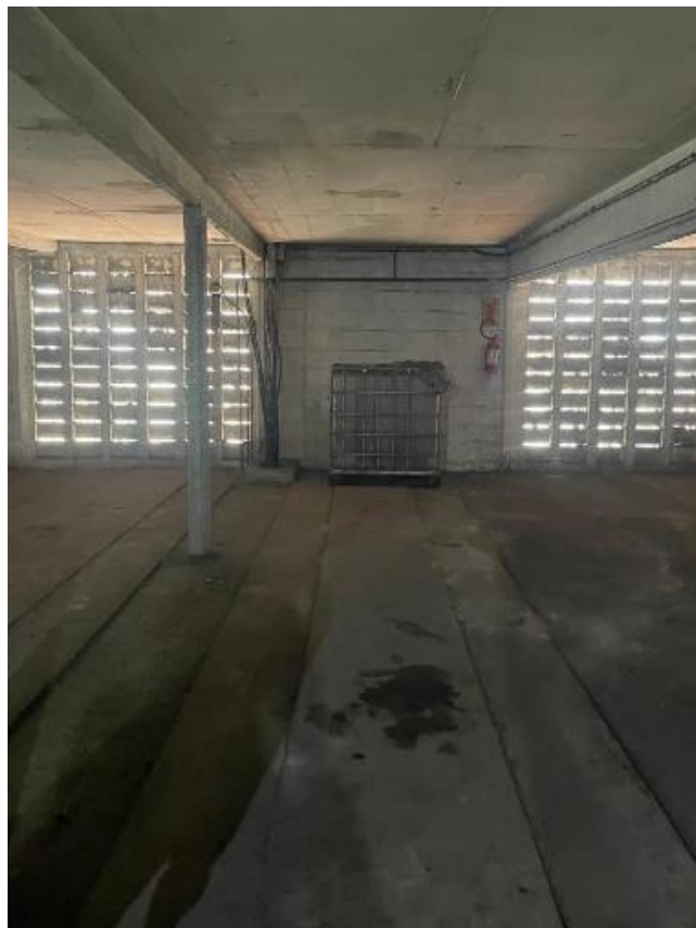
Foto 03 Vista da parcial Box da Garagem
