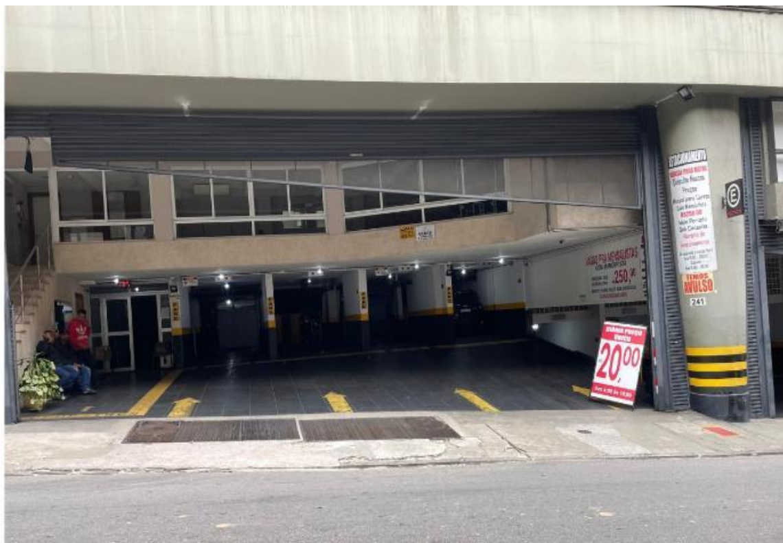
Foto 01 Vista da fachada da Garagem
