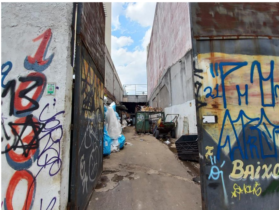
Figura 6. Entrada do terreno
