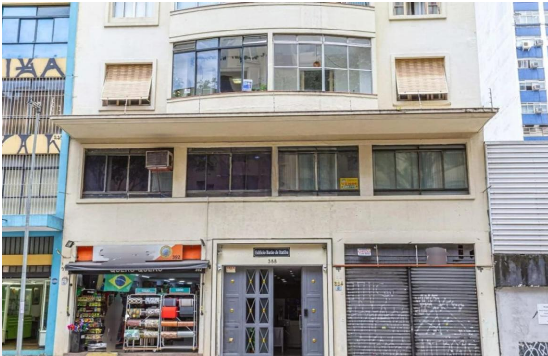
Figura 1 - Fachada do prédio/entrada
