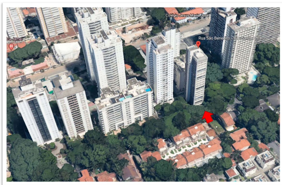
Fig. 05 – Vista aérea da microrregião do imóvel
