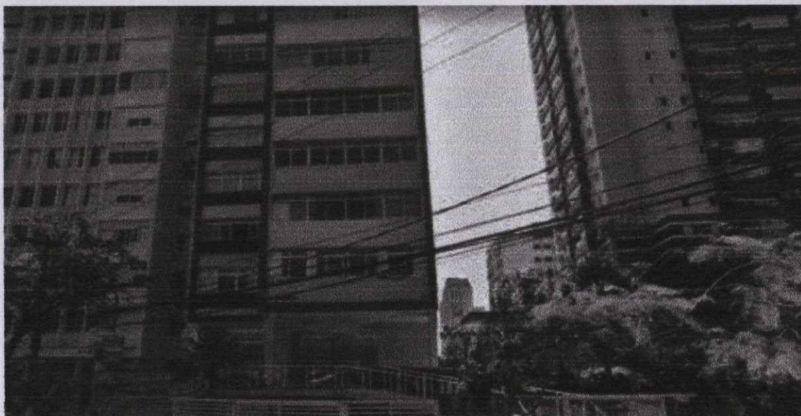
Imagem 5: Edifício São Luis – entrada para pedestres
