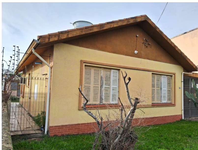
Fotos 1 e 2 – Vistas da frente do imóvel pela rua Alberto Albertini.
