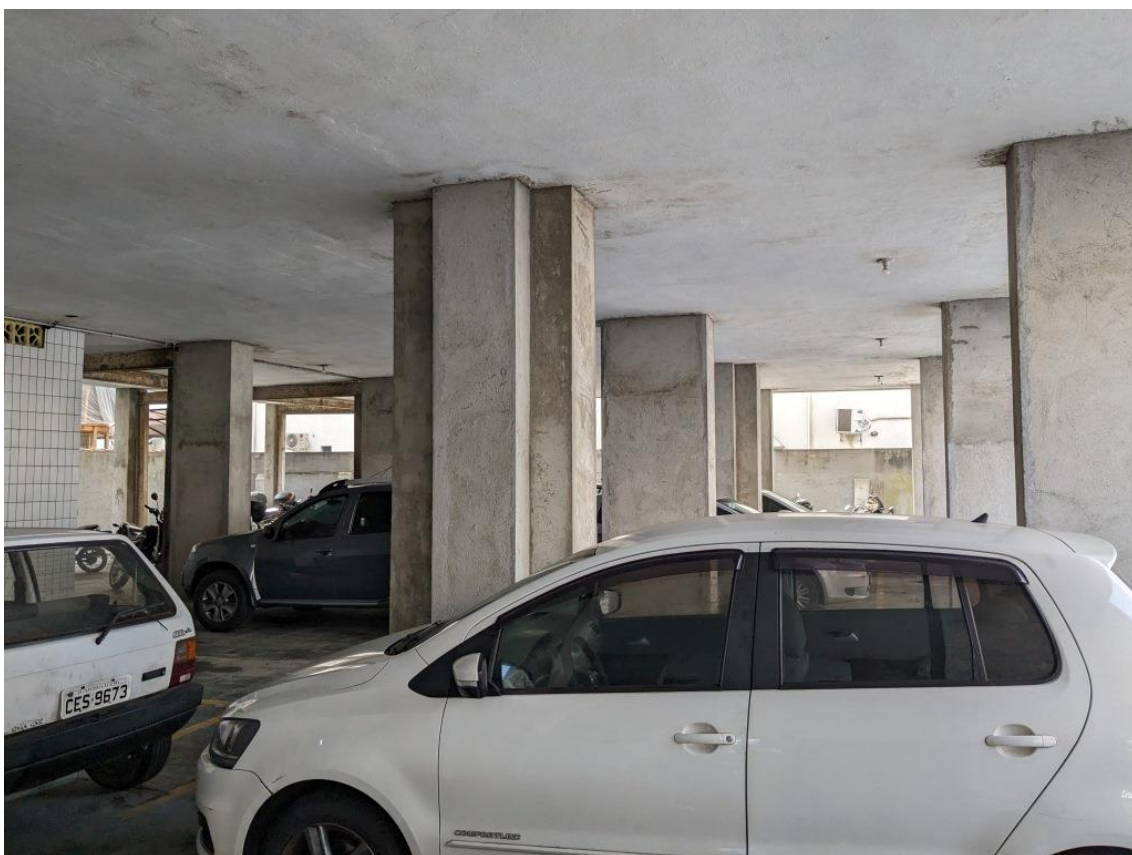
Fotos 17 e 18 – Vagas de garagens no pavimento térreo
