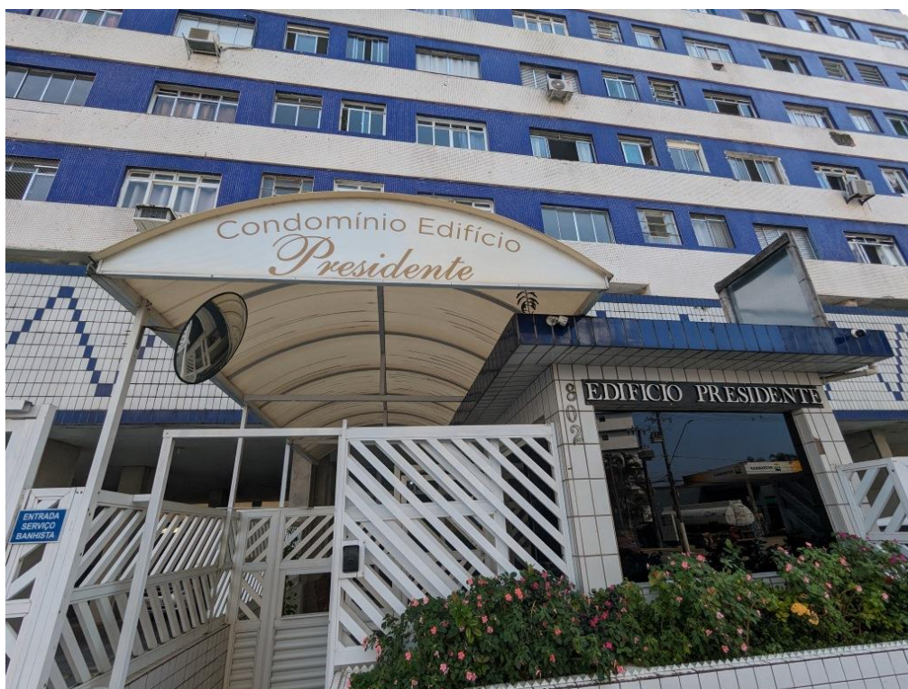
Foto 2 – Portaria e entrada do Edifício Presidente.
