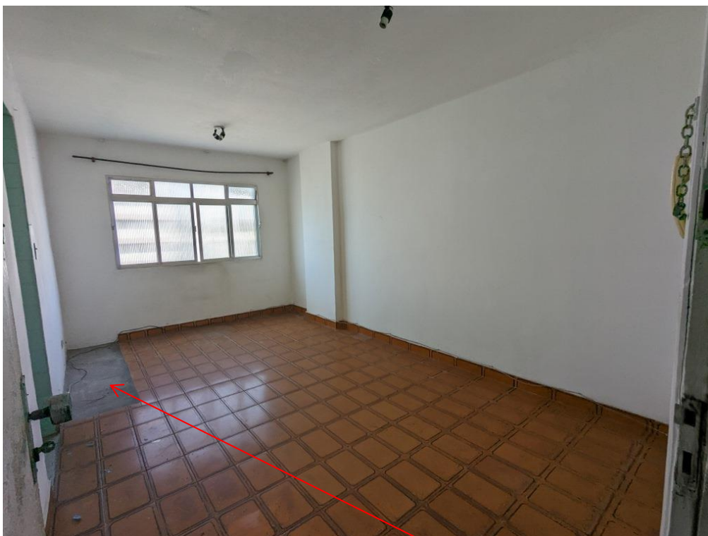
Foto 8 – Vista da sala-living do imóvel; trecho de piso foi removido
