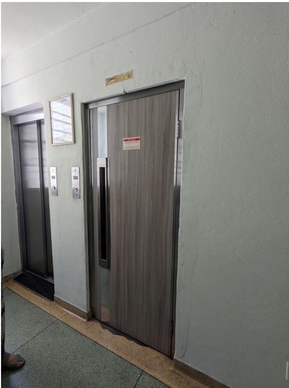
Foto 4 – Hall social do 9º pavimento, onde se localiza o apartamento avaliando; os elevadores não param exatamente nos andares
