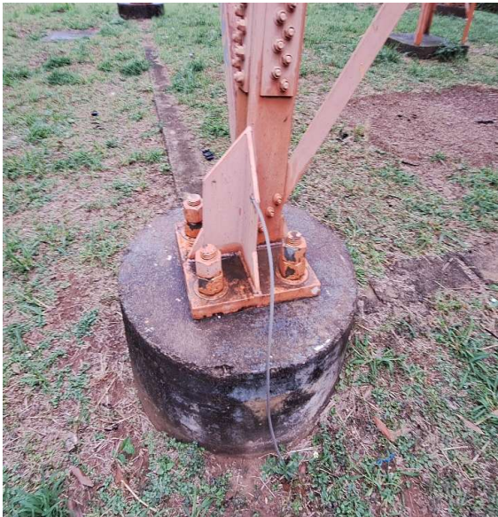
Det. Fixação Antena
