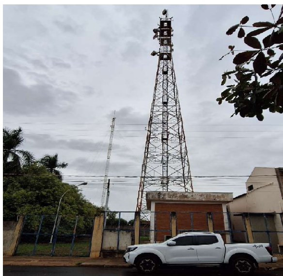
Vista Geral com antena
