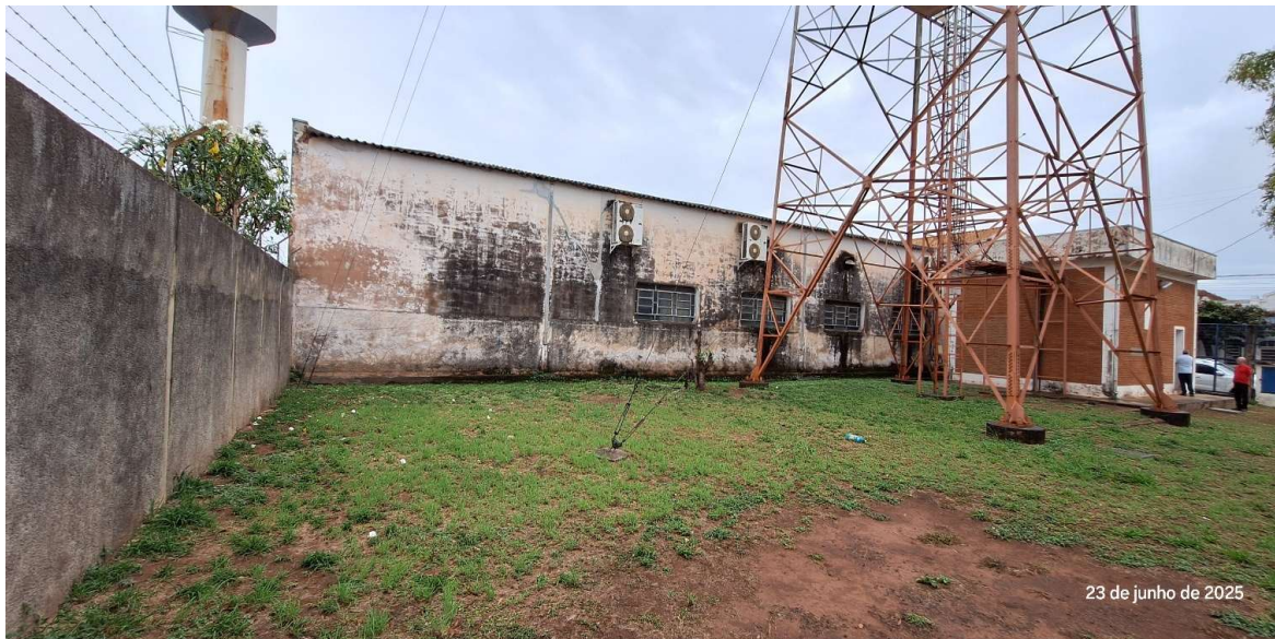
Vista Interna do Lote e Vista Geral da Antena e Galpão
