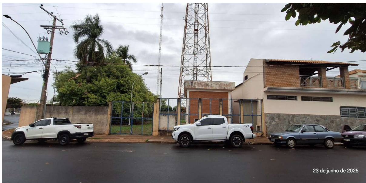
Fachada do imóvel - Rua Manoel Marquês, nº 235 - Vista Alegre do Alto
