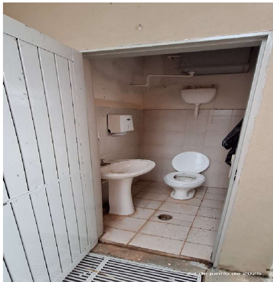
Vista Interna do Banheiro
