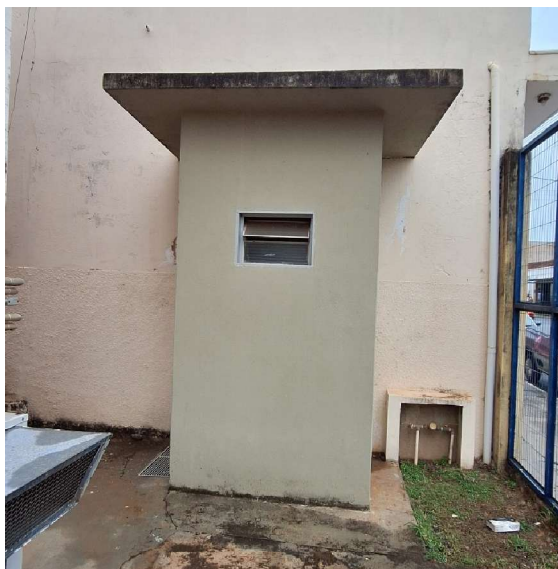
Vista Externa do Banheiro
