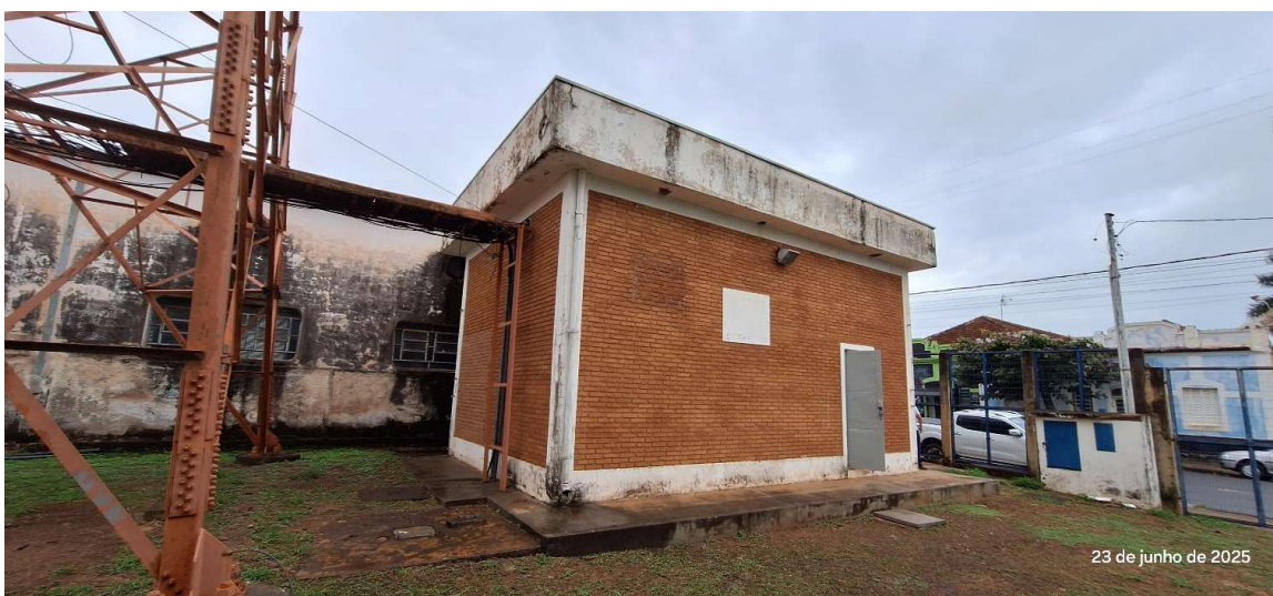
Vista Geral do Galpão
