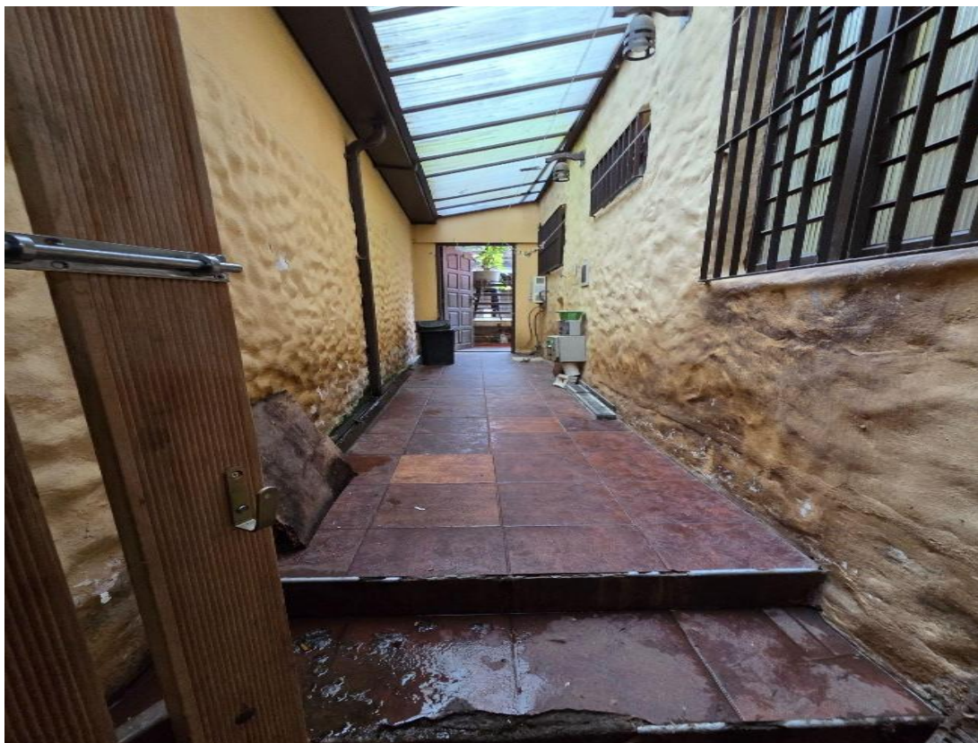
Corredor de acesso a área de lazer e edícula no 1º pavimento superior.
