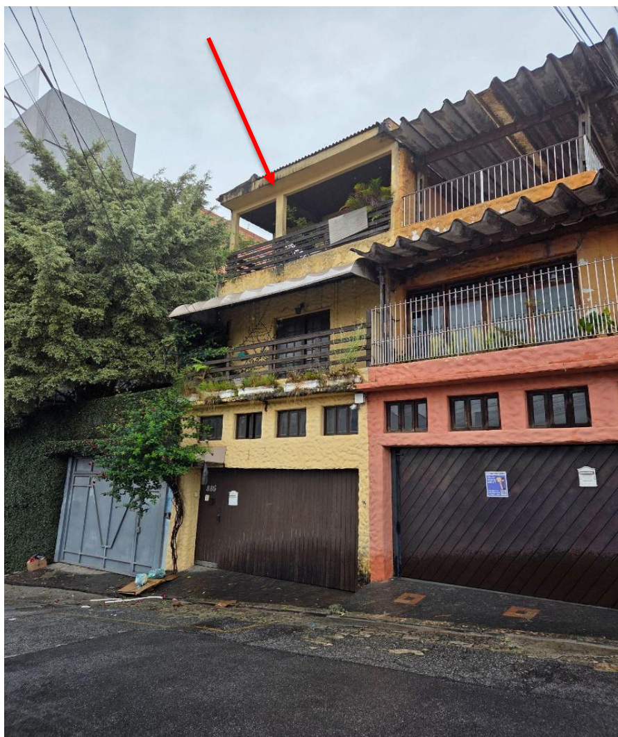
Fachada do imóvel vista da Rua Manuel Correia.
