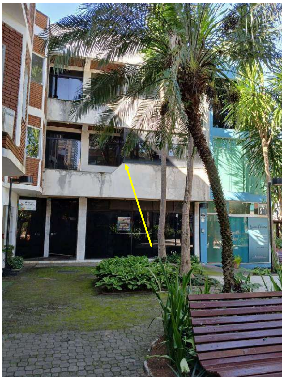
Fachada do imóvel vista da Praça das Flores.
