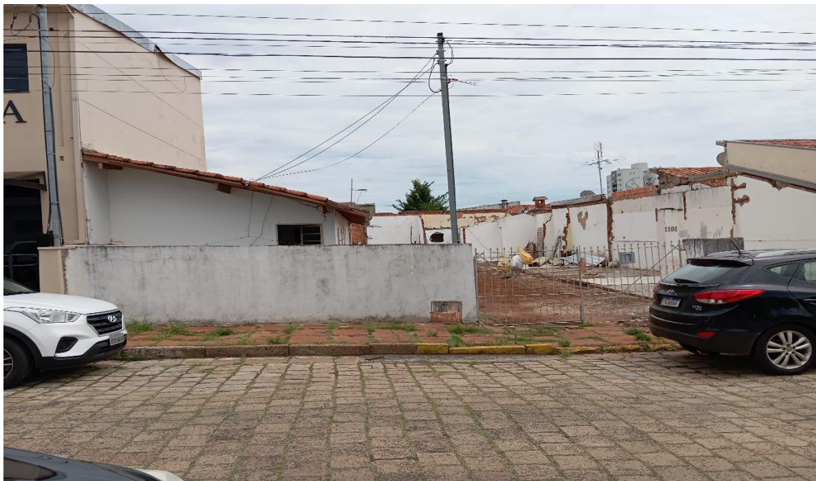
Vista frontal do imóvel situado à Rua Sérgio Bernardino 1.191, Centro, Avaré/SP.
