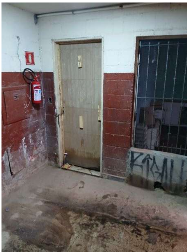
Porta de acesso ao interior do apartamento nº. 12 E.
