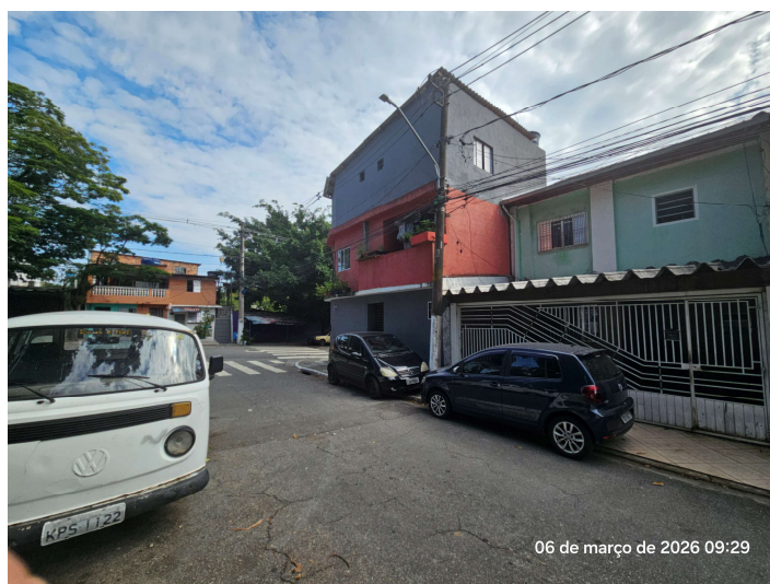
Figura 6 - Vista da Rua Acapurana
