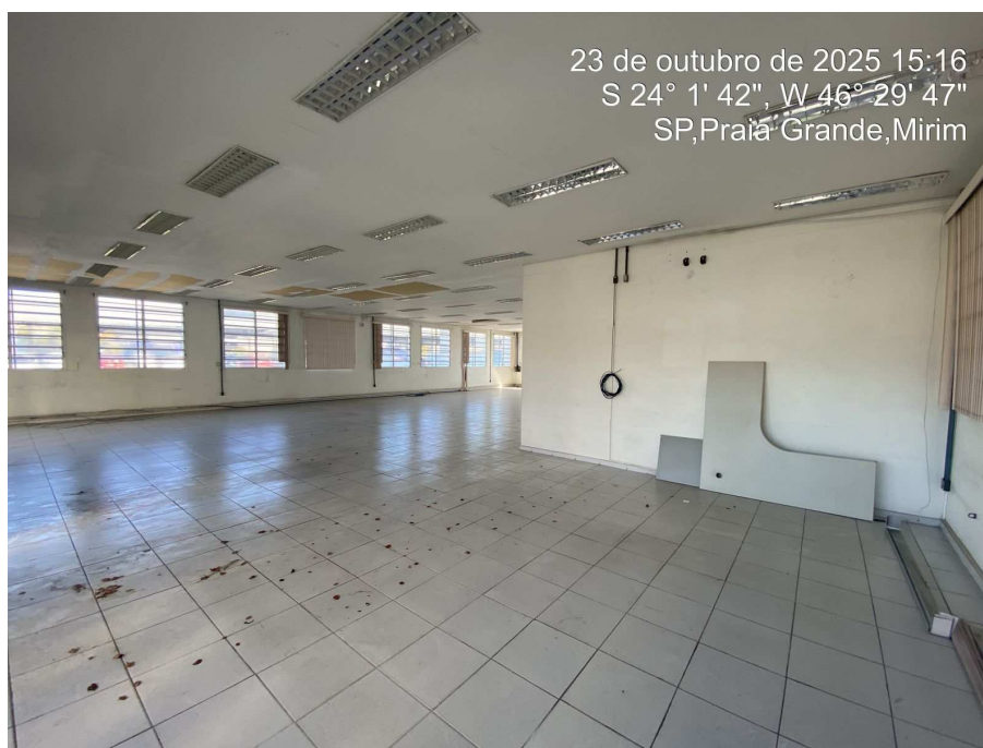
Foto 18: Outra vista do salão.
