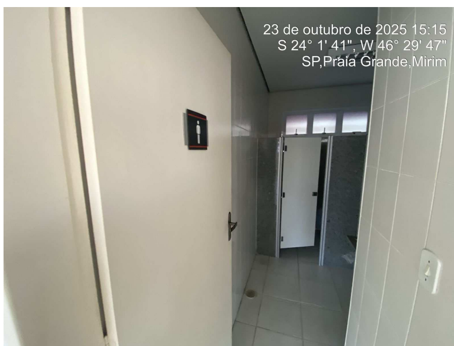
Foto 16: Vista dos banheiros.
