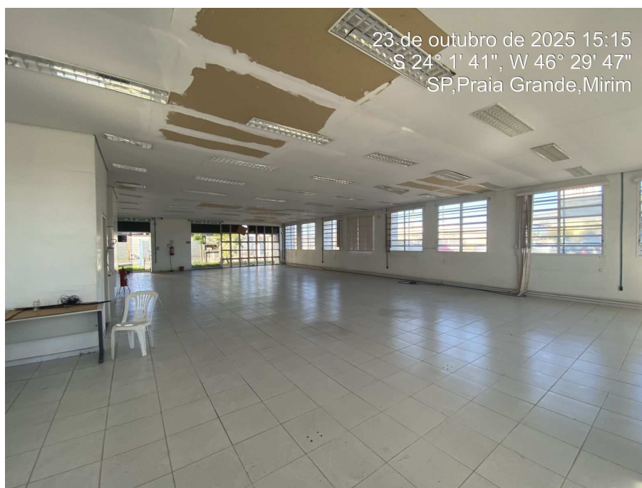
Foto 14: Outra vista do salão.
