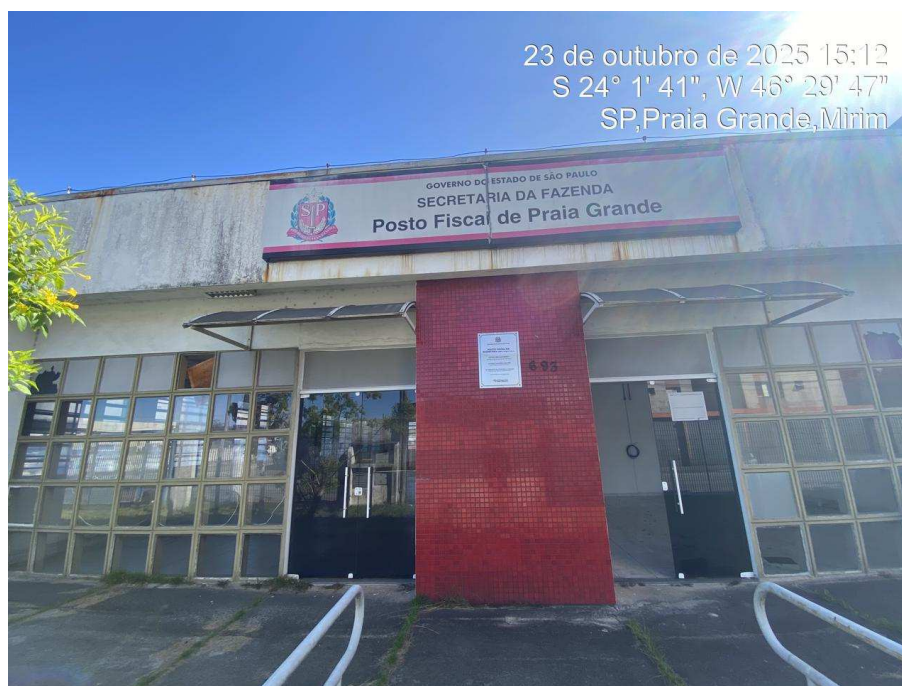
Foto 6: Vista da fachada.
