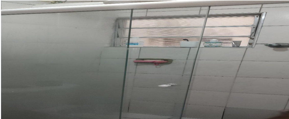
Figura 23: Vista do banheiro social, outro ângulo.
