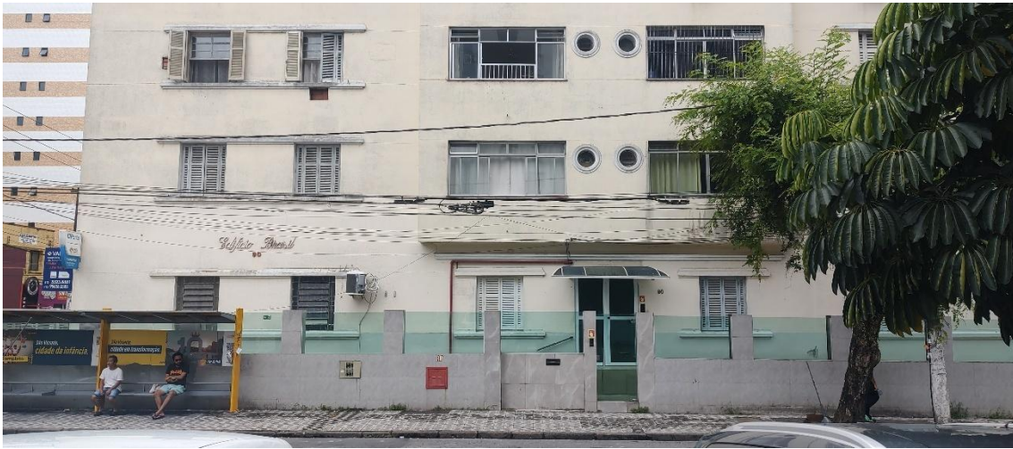
Figura 2: Frente do Edifício.
