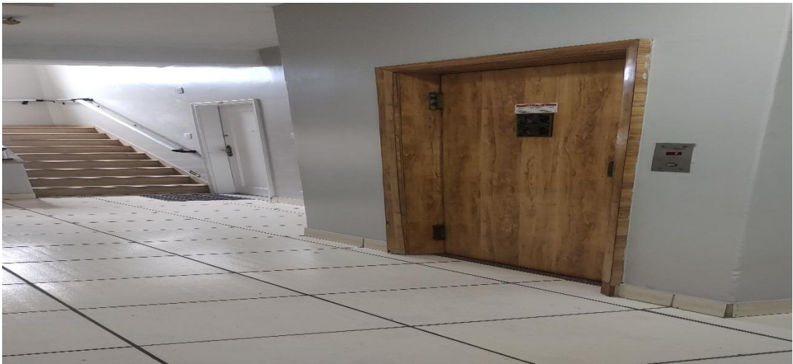
Figura 24: Hall de acesso ao imóvel.
