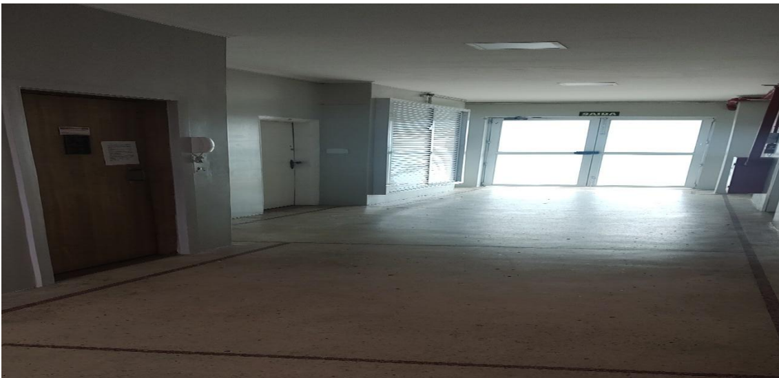
Figura 25: Hall de acesso ao Edifício.
