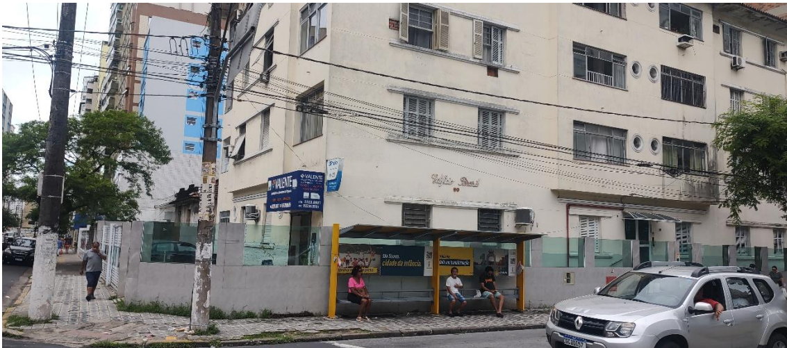
Figura 3: Vista da esquina do edifício.
