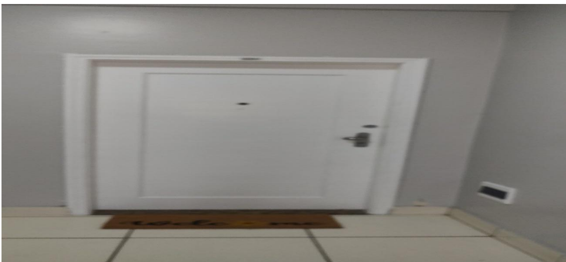
Figura 4: Porta de entrada ao apartamento 201.
