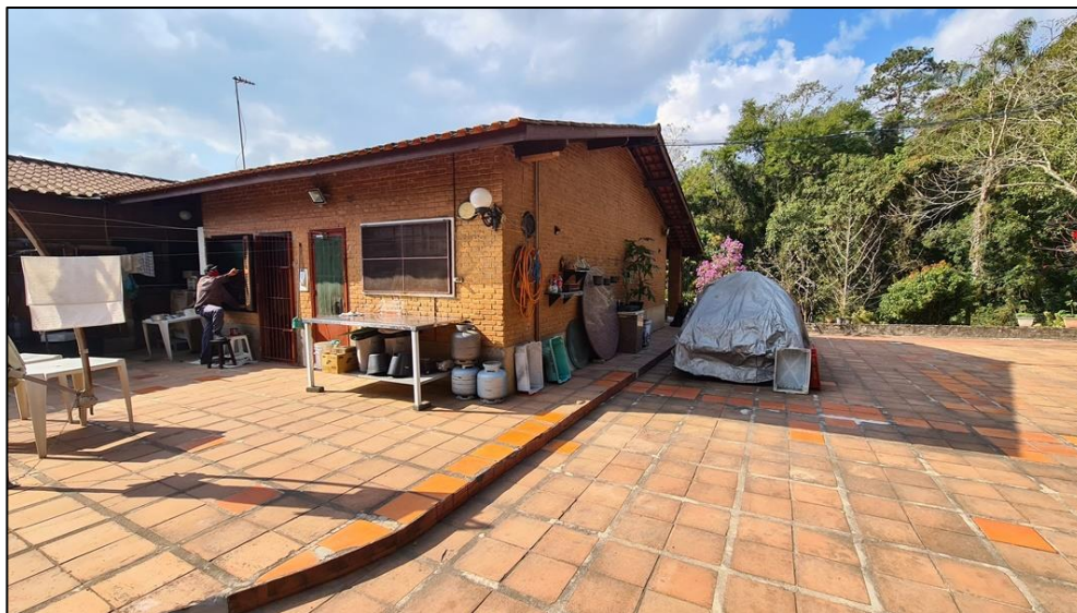
Foto 8 – Fundos da construção
