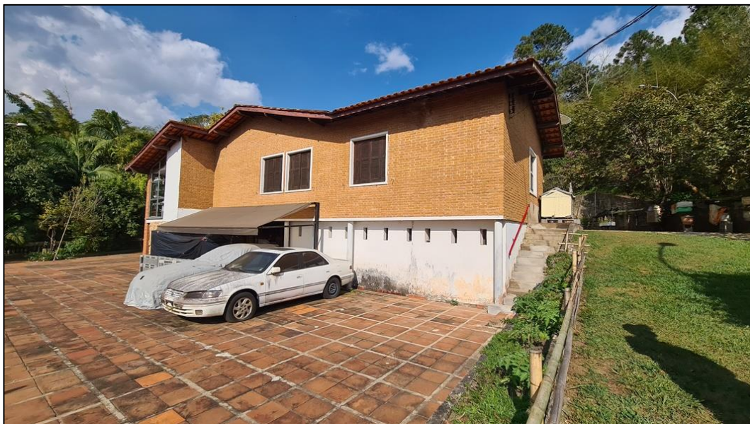
Foto 03 – Frente da construção
