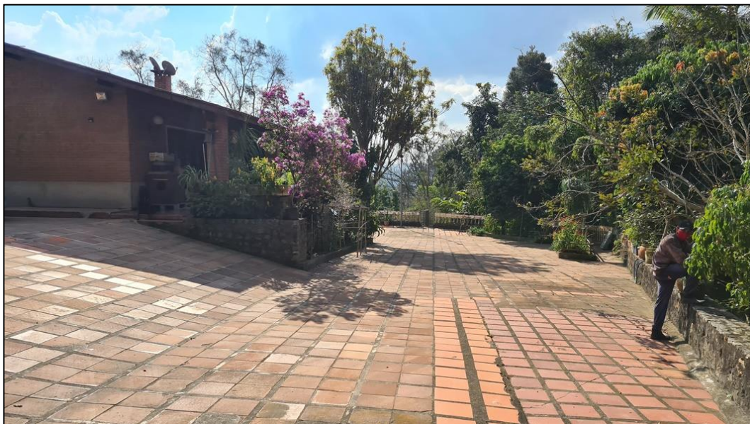
Foto 04 – Lateral da construção
