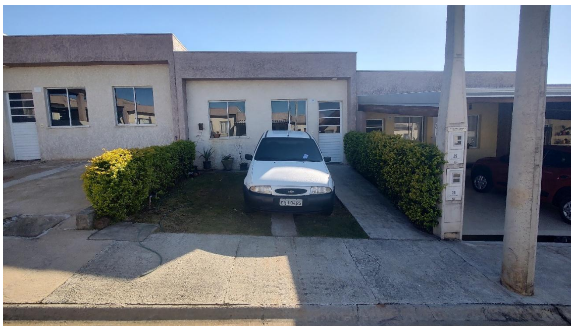
Fachada da casa 36
