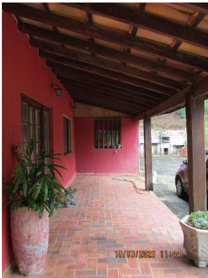
Varanda externa (ângulo III)
