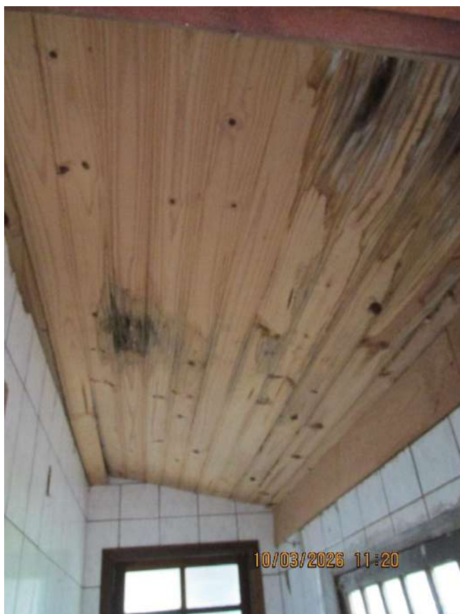
Banheiro apoio II/Teto
