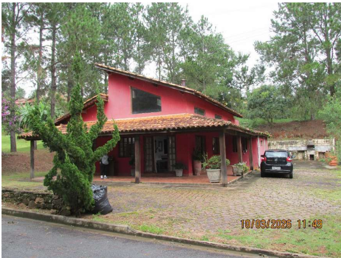
Fachada do Imóvel Periciando
