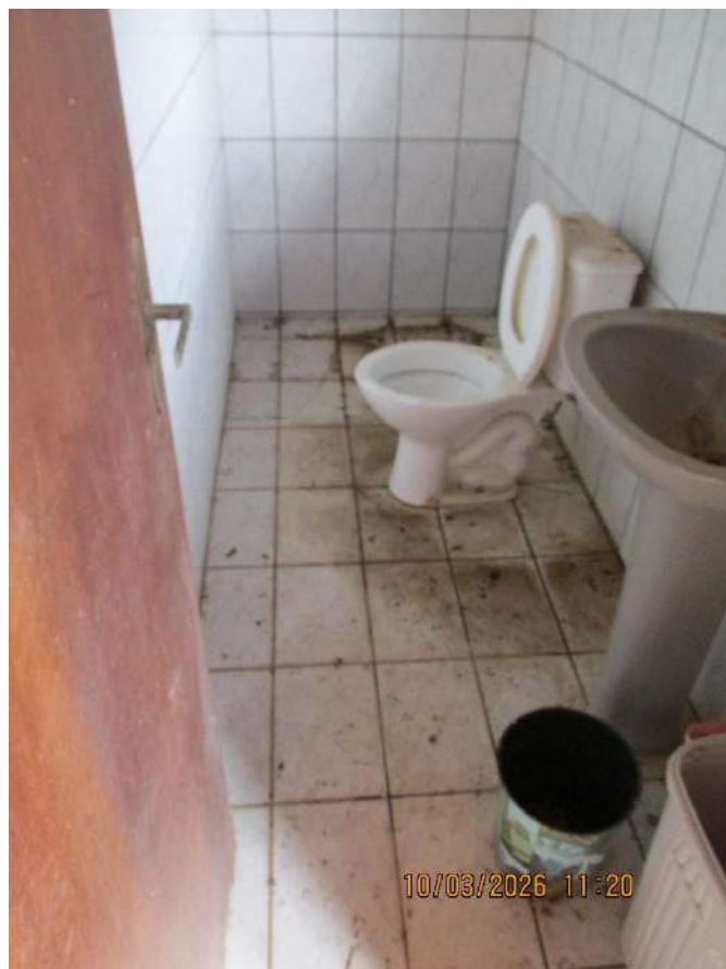
Banheiro apoio II/Piso
