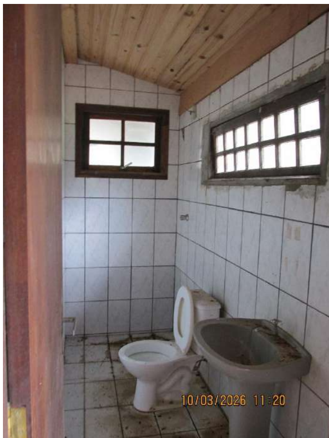
Banheiro apoio II
