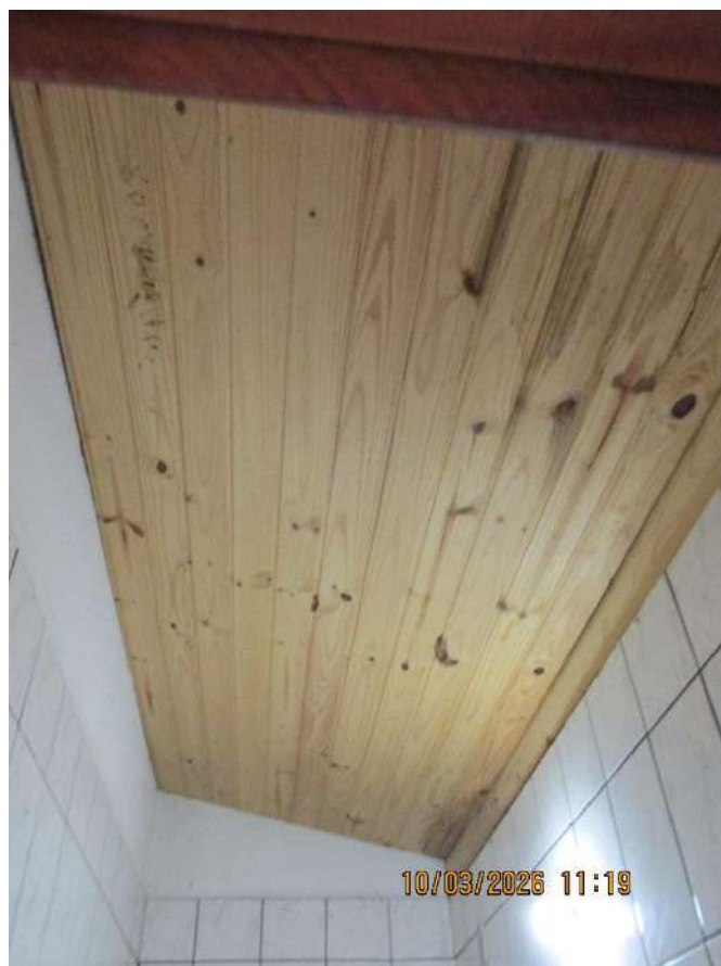
Banheiro apoio I/Teto
