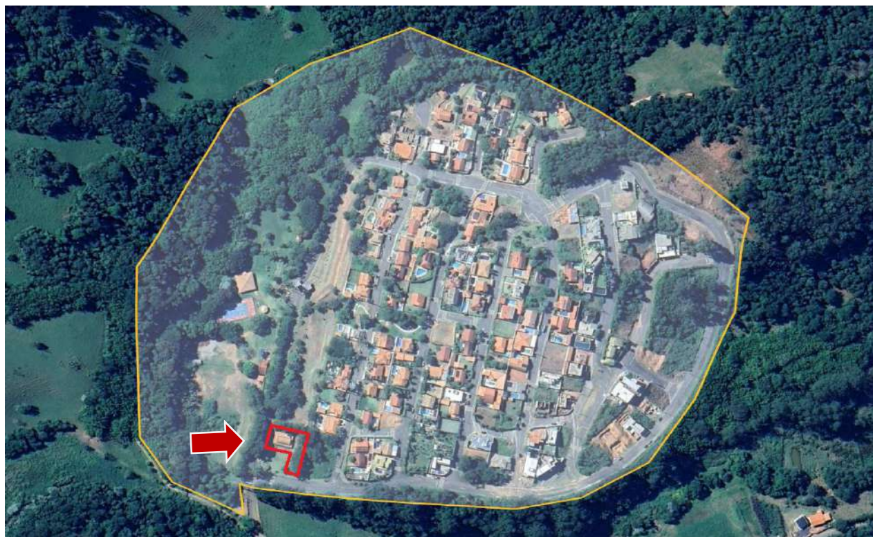
Localização do Imóvel no Condomínio
