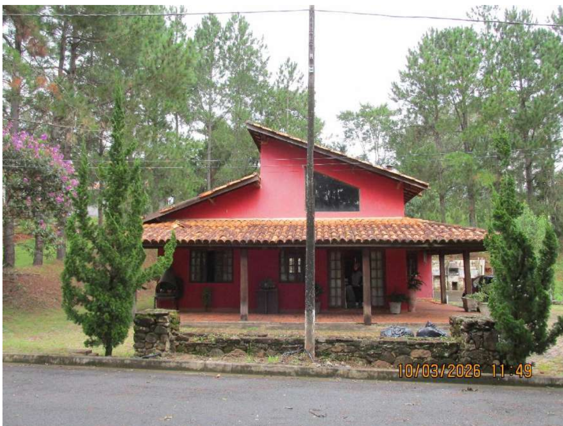
Fachada do Imóvel Periciando
