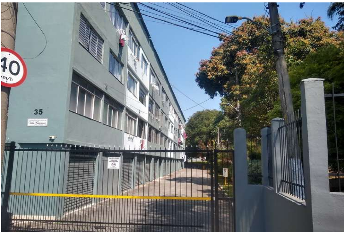
FOTO nº 05 Vista do acesso para autos no Prédio nº 35.
