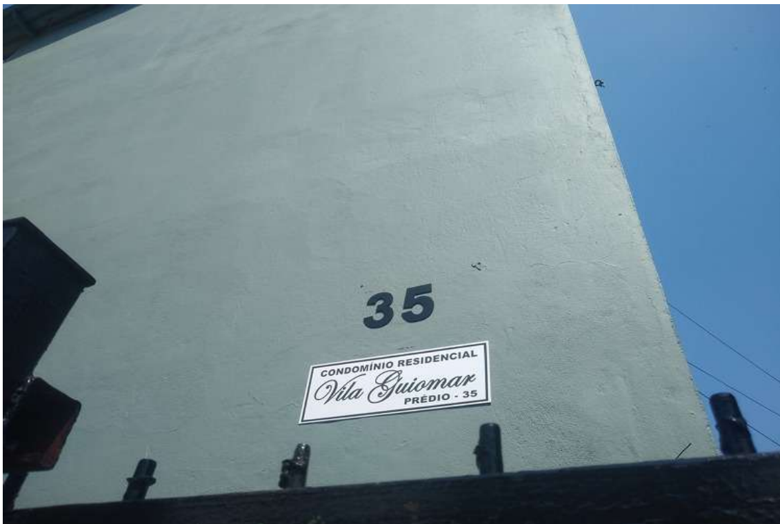
FOTO nº 04 Vista da identificação condominial na fachada frontal predial.
