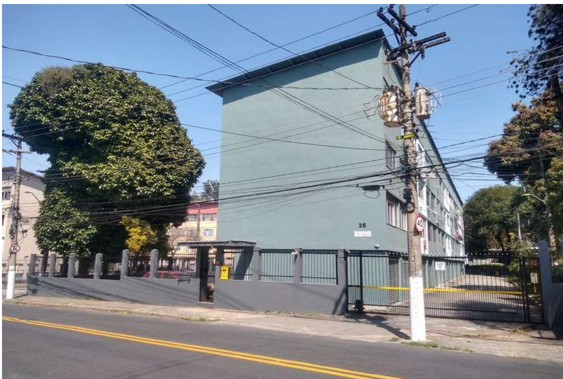
FOTO nº 03 Vista do Prédio nº 35 no Conjunto Residencial de Vila Guiomar.
