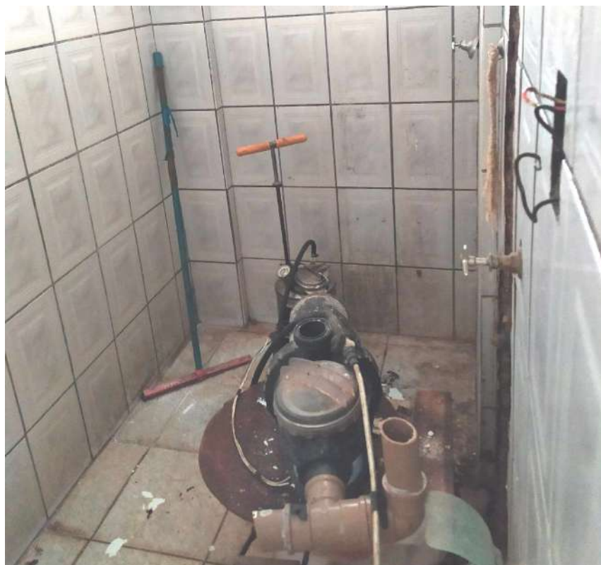
Foto 9 – Detalhe para o banheiro do imóvel.
