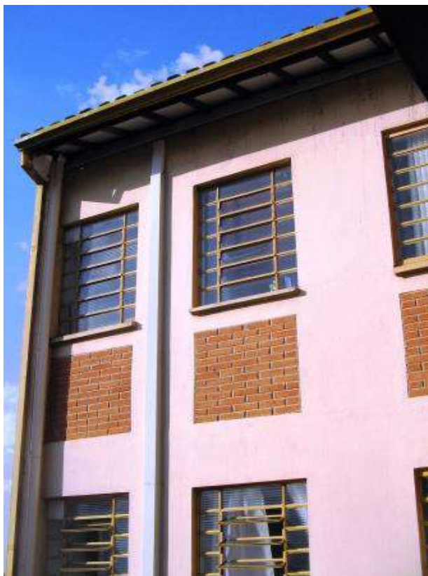
Foto 2 – Detalhe da fachada do Bloco 270-F
