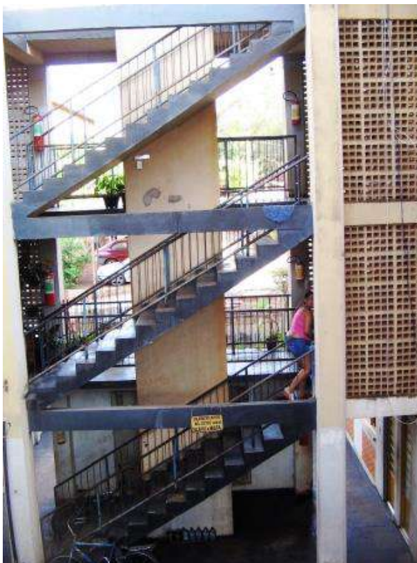
Foto 4 – Detalhe das escadas, no bloco onde está o apartamento periciado.
