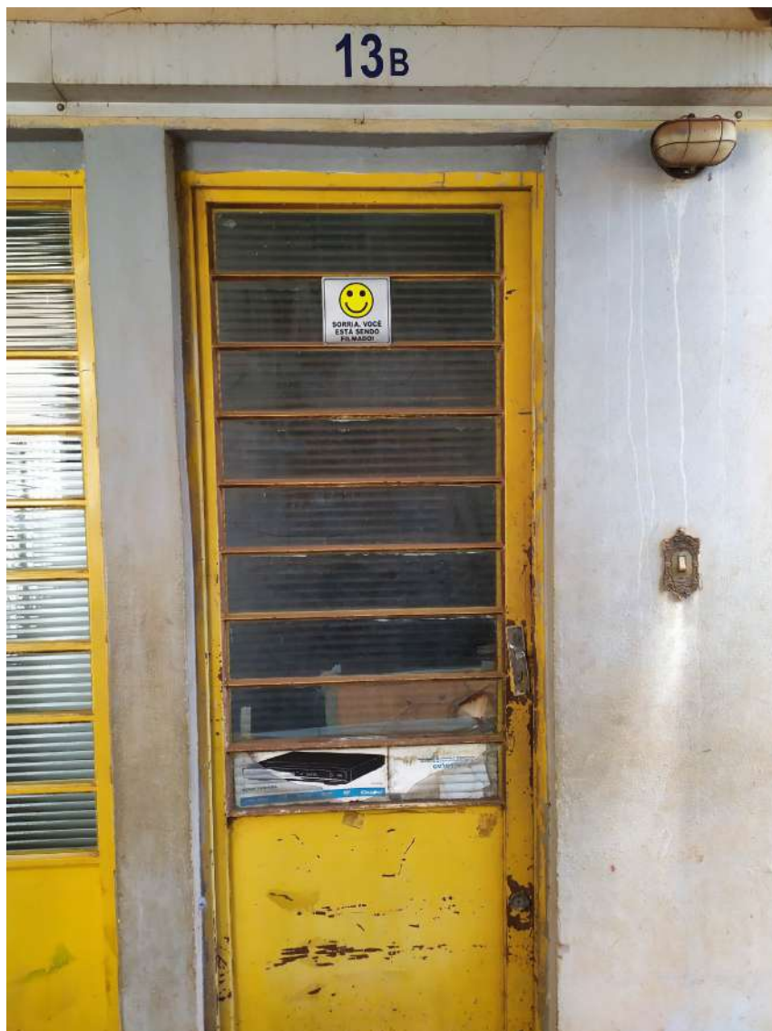
Foto 3 – Porta de entrada do apartamento periciado.
