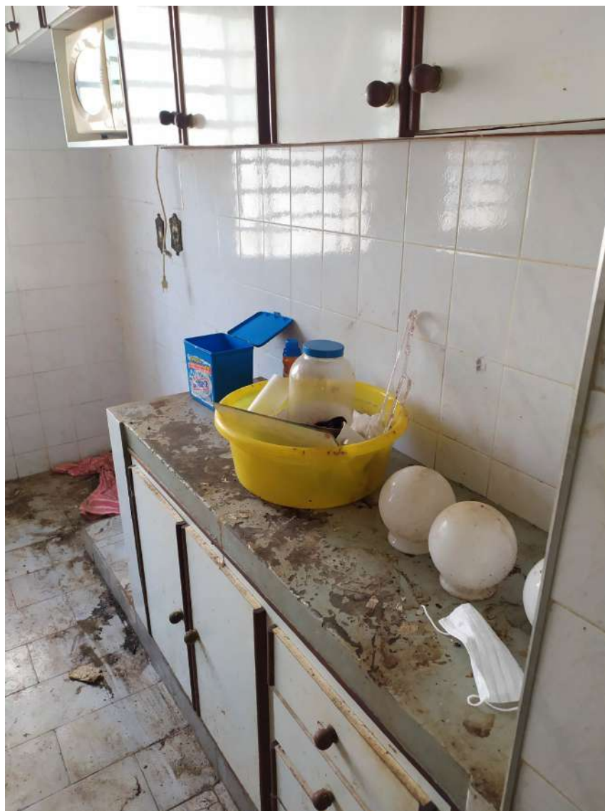
Foto 13 – Vista da cozinha à direita a partir da entrada do ambiente.
