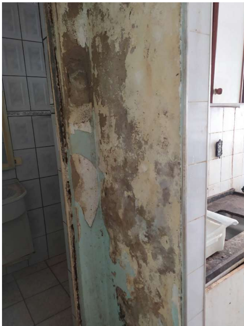
Foto 11 – Detalhe para a parede do corredor entre o banheiro à esquerda e a cozinha à direita.
