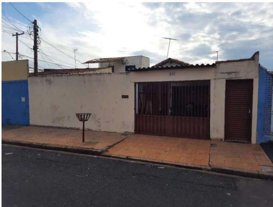
Foto 1 - Fachada do imóvel
