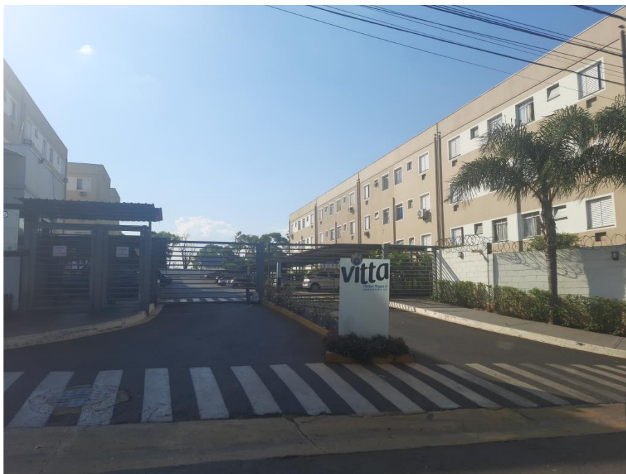
Foto 1 - Vista da fachada do condomínio
