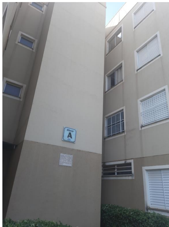
Foto 4 - Vista parcial do bloco A e sua identificação
