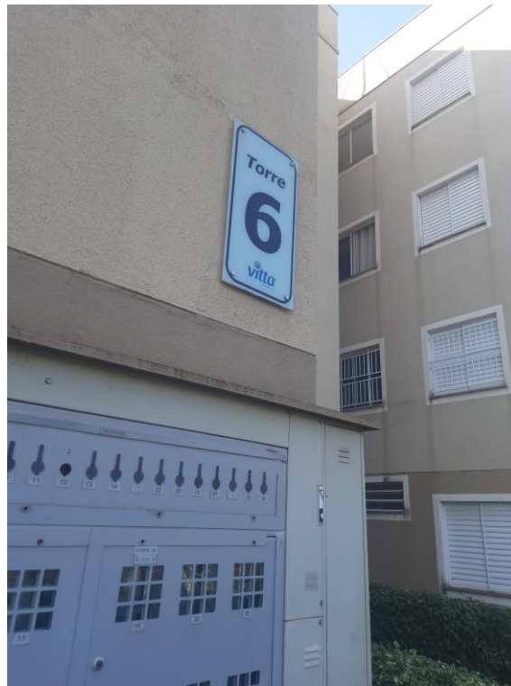
Foto 3 - Vista parcial da torre 06 do condomínio e sua identificação
