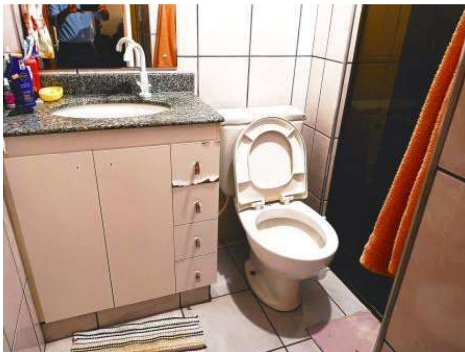
FOTO 13 Banheiro do apartamento periciado.
