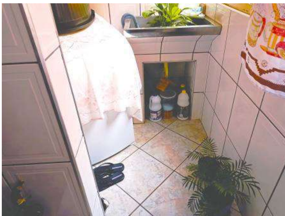
FOTO 10 Área de serviço do apartamento periciado.
