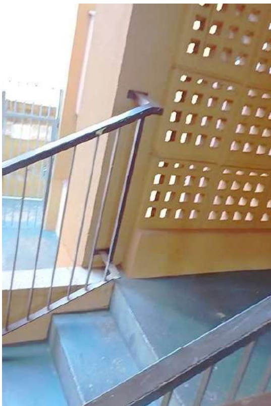
FOTO 15 Detalhe da escada interna.
