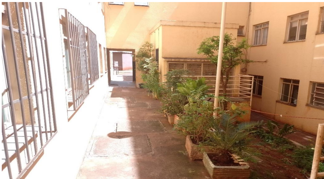
Foto 06: Vista externa do imóvel
