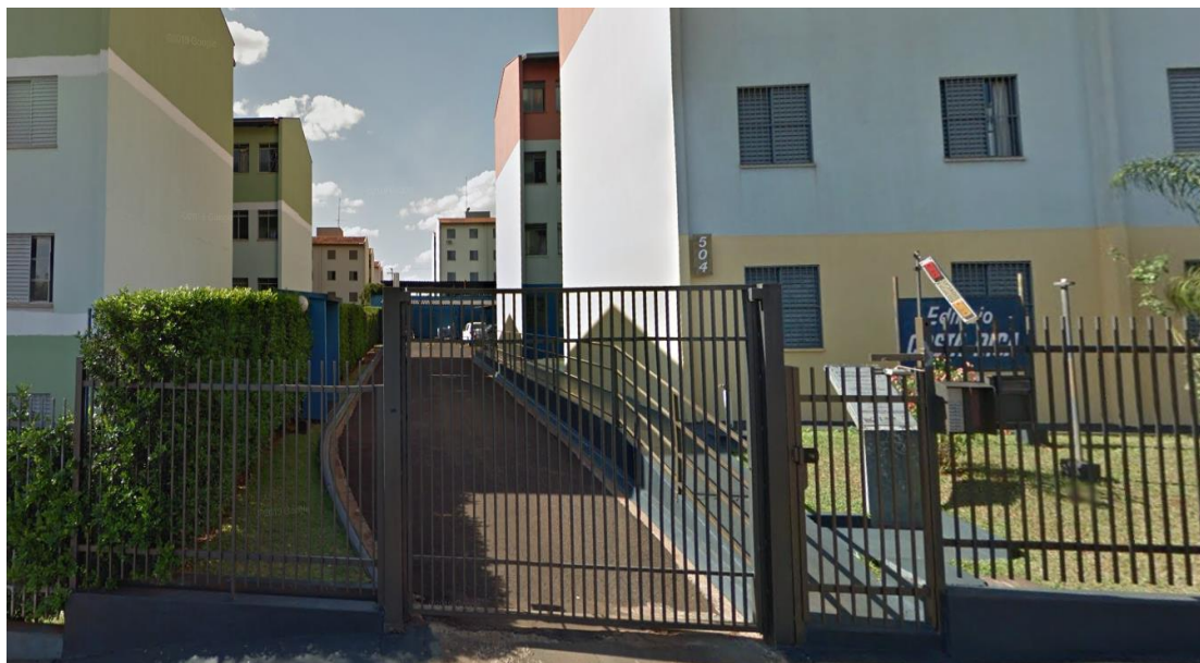
Foto 05: Vista externa do imóvel
