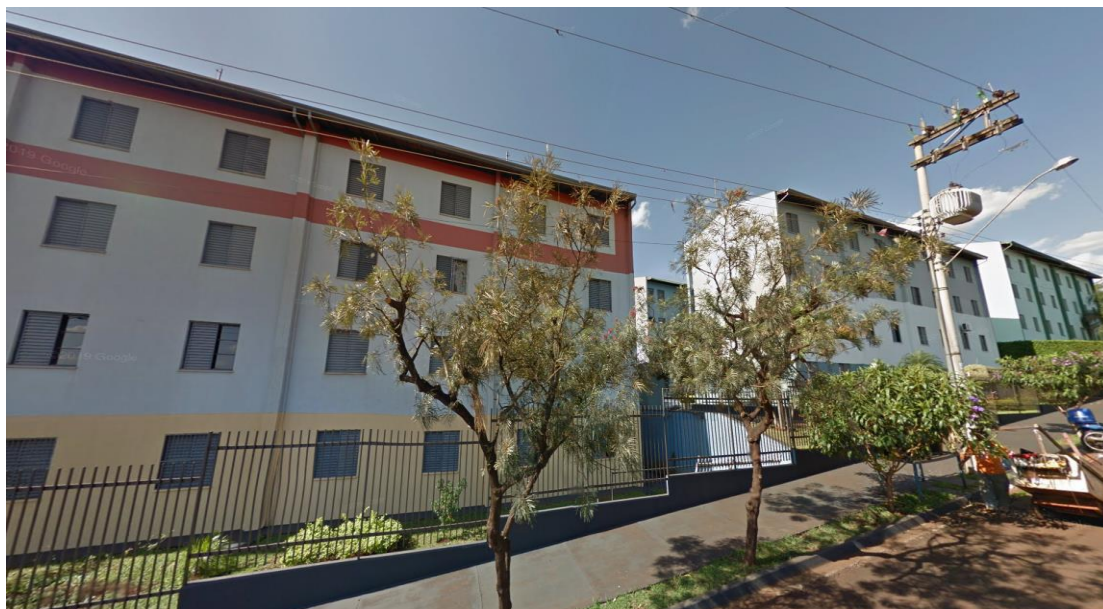
Foto 03: Vista Externa do imóvel.
