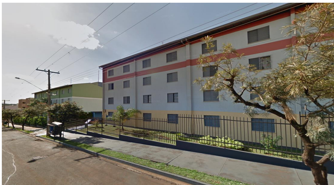
Foto 02: Vista externa do imóvel
