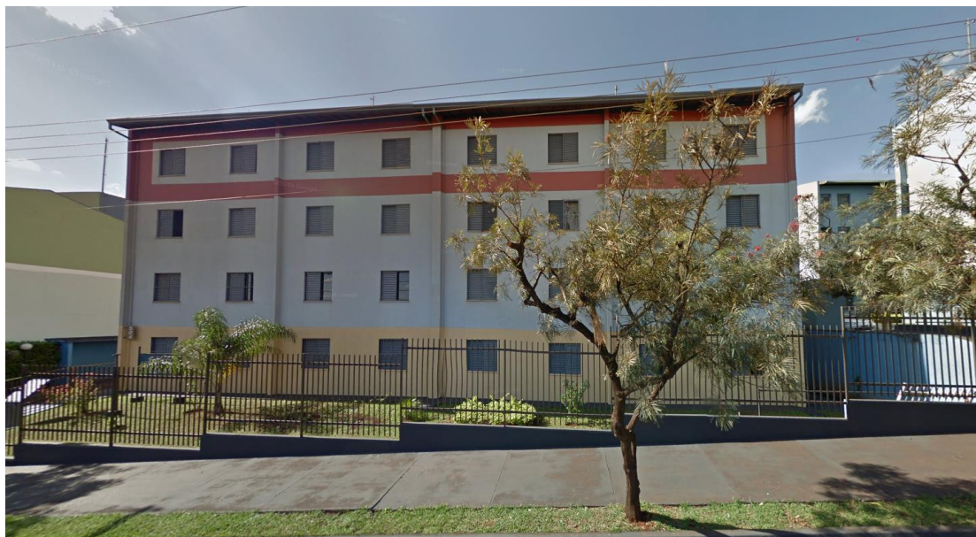
Foto 01: Vista externa do imóvel
