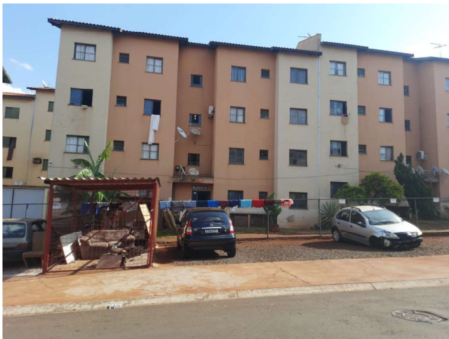
Foto 4 - Vista da fachada do Bloco 03
