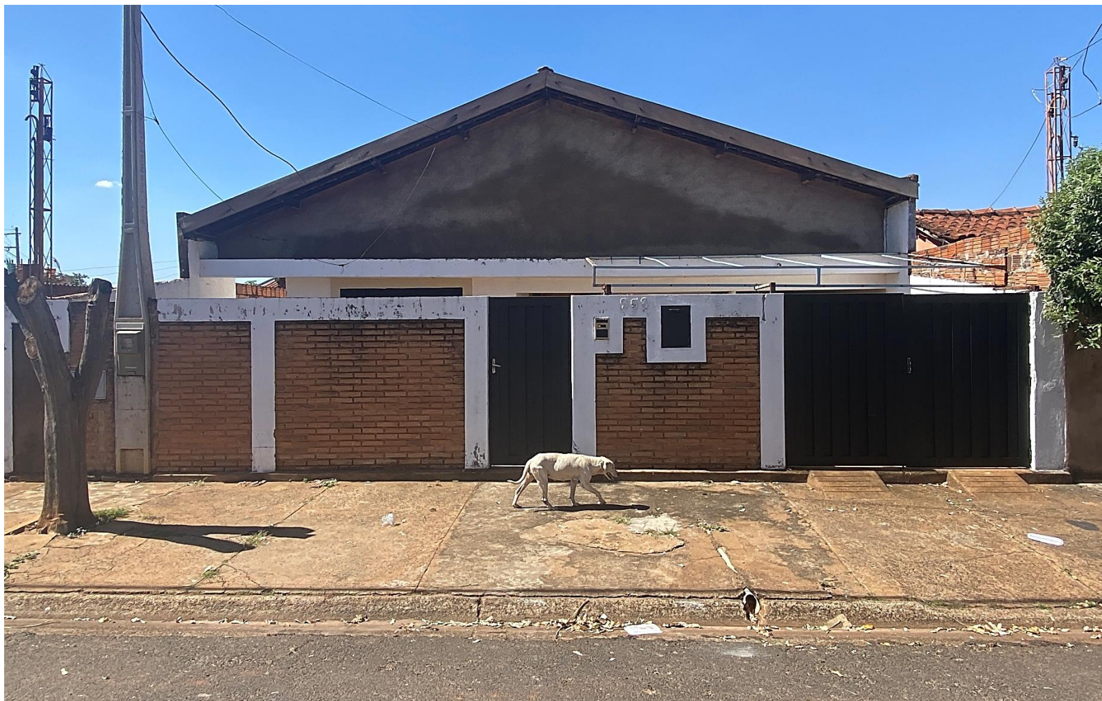
VISTA GERAL DA FACHADA DO IMÓVEL AVALIANDO PELA RUA EMÍLIO JOSÉ PINTO.
