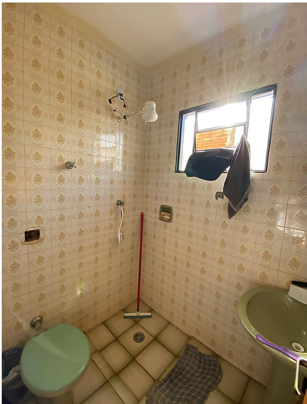
VISTA GERAL DO OUTRO BANHEIRO SOCIAL, COM ACESSO PELA COZINHA.
