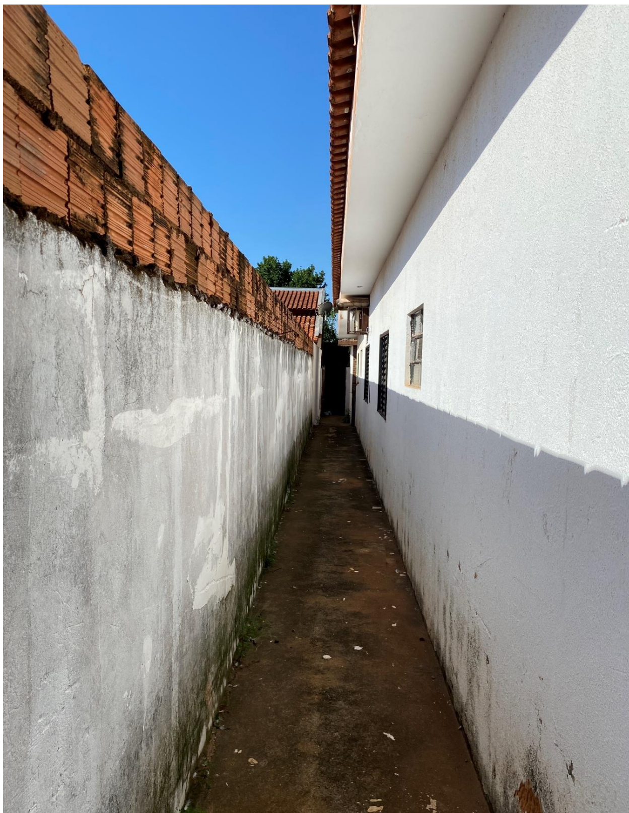
VISTA GERAL DO CORREDOR NA LATERAL ESQUERDA DA EDIFICAÇÃO.
