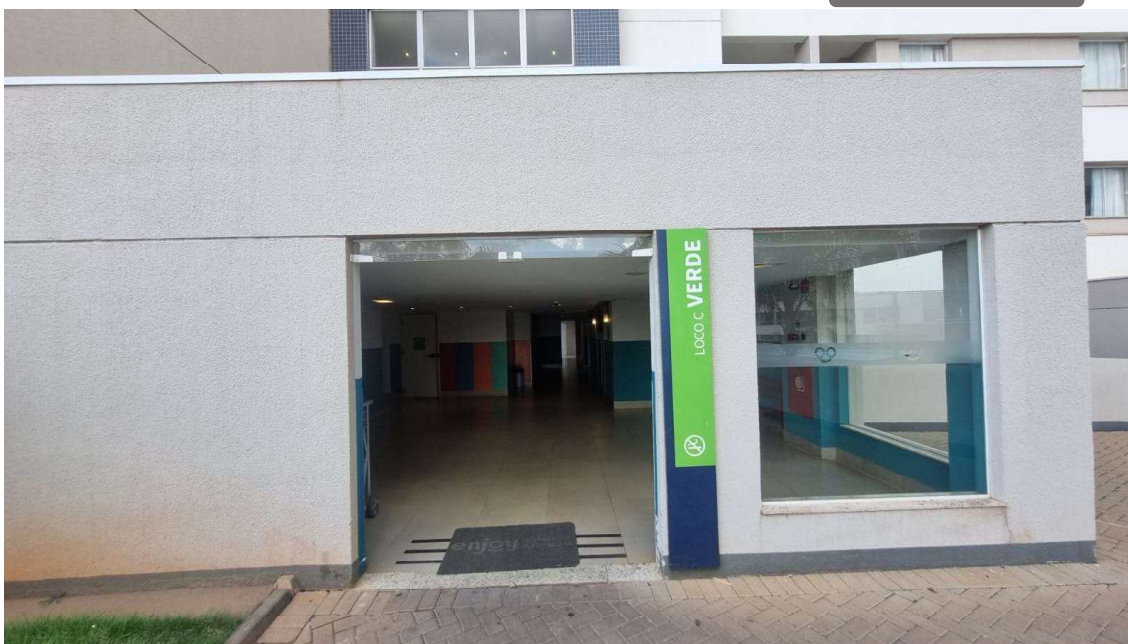
Foto 07 – Entrada do Bloco C.
