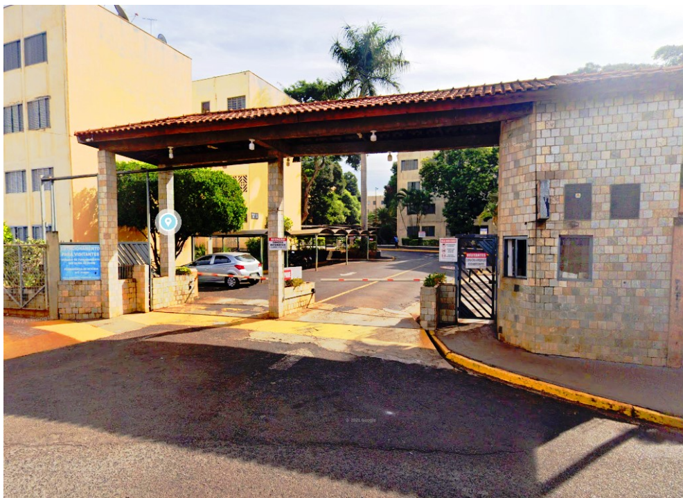
FOTO 1 Vista frontal do conjunto habitacional D'Elboux, Quadra B
