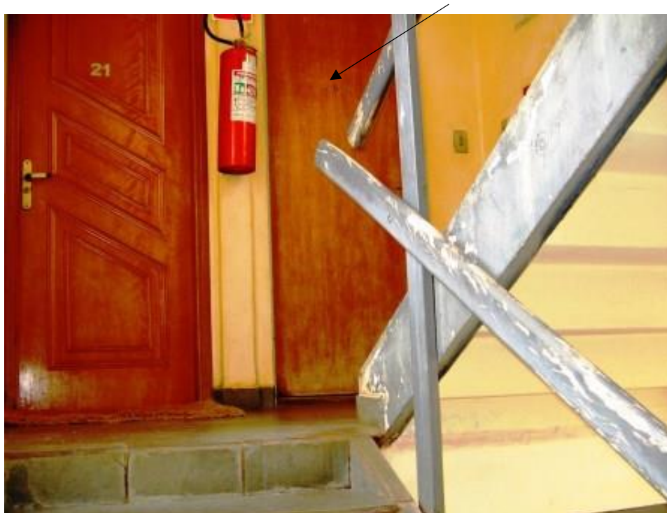
FOTO 2 Escada de circulação vertical, chagando-se à porta do apartamento periciado, Indicada pela seta preta.
