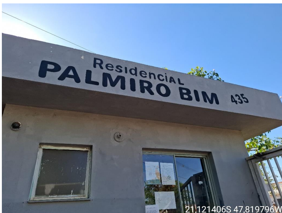
Foto 2 - Vista da identificação do Residencial Palmiro Bim
