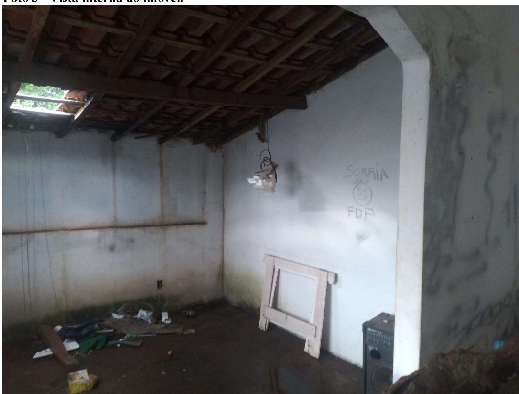
Foto 4 - Vista interna do imóvel.
