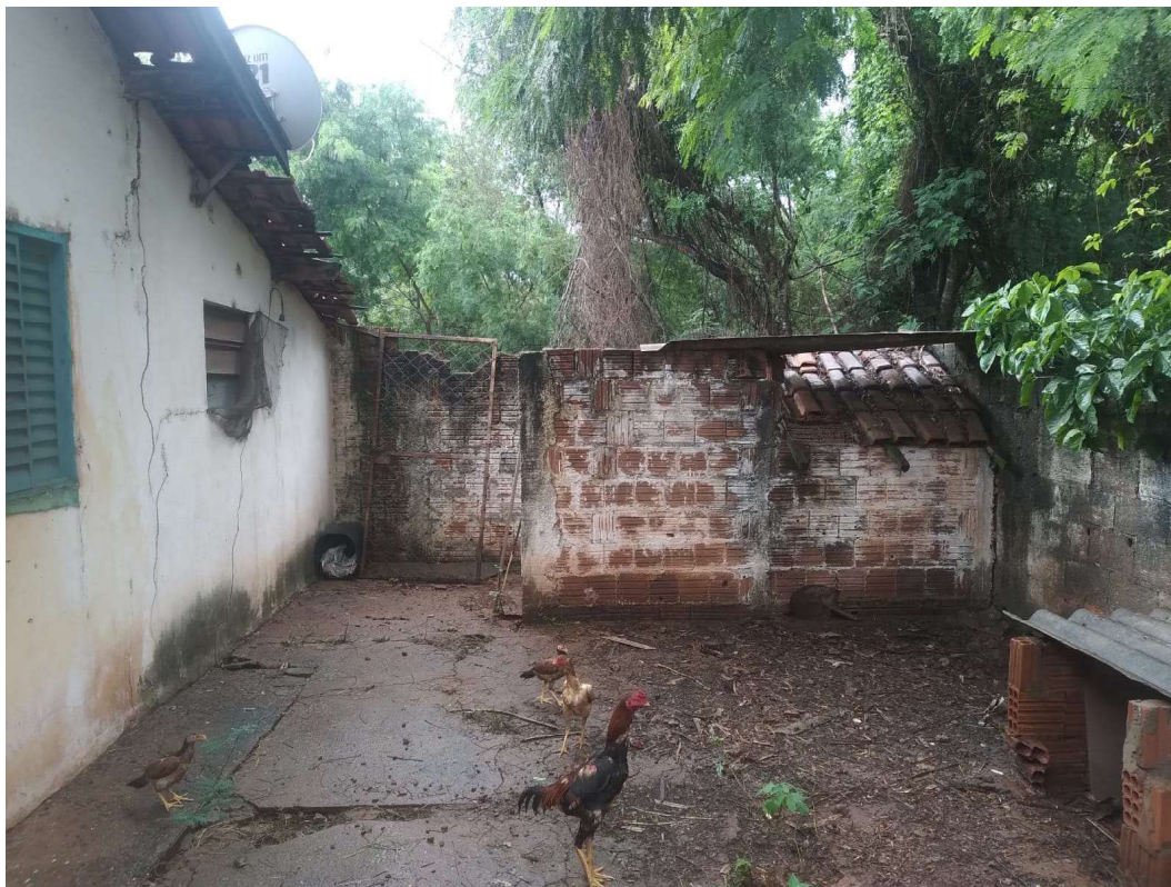
Foto 9 - Vista externa do imóvel.
