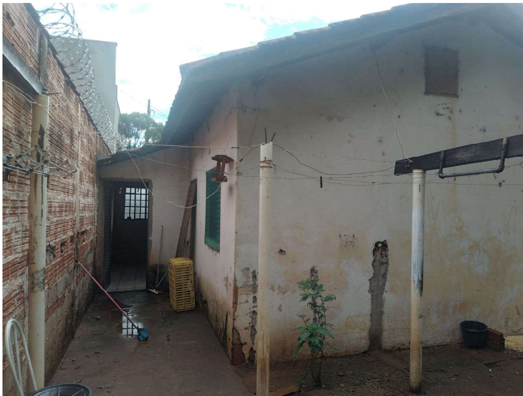
Foto 7 - Vista externa do imóvel.
