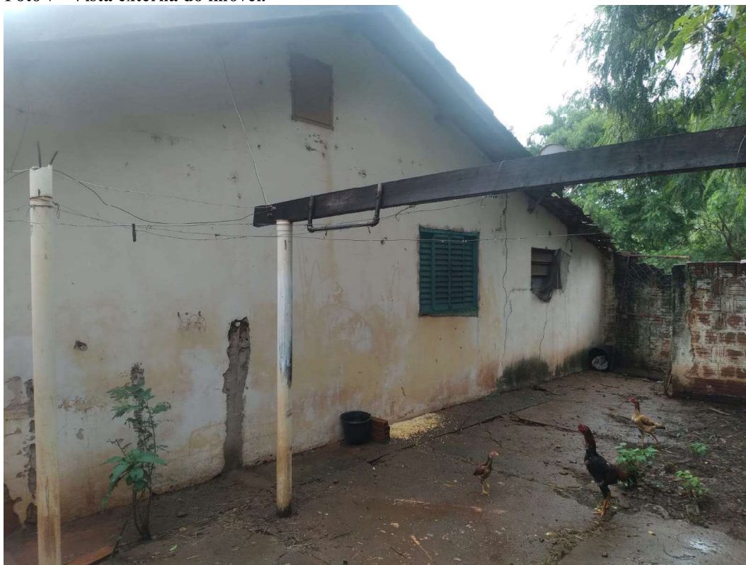
Foto 8 - Vista externa do imóvel.
