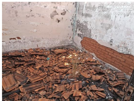
Figuras 7 e 8: Desabamento do telhado em virtude de incêndio.
