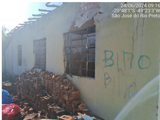
Figuras 11 e 12: Verificação da existência de trincas importantes nas alvenarias.
