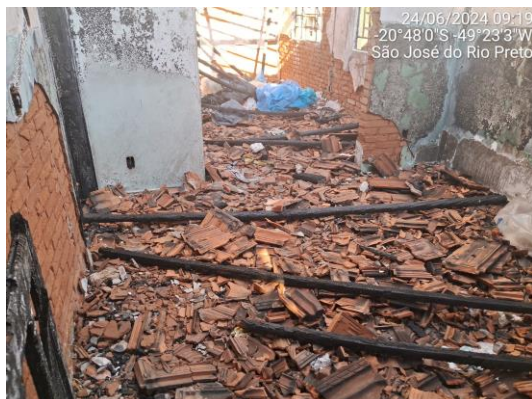
Figuras 7 e 8: Desabamento do telhado em virtude de incêndio.
