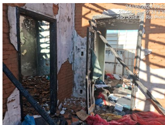
Figuras 9 e 10: Verificação da ausência de estrutura de concreto nas paredes.
