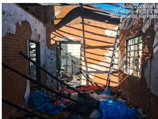
Figuras 9 e 10: Verificação da ausência de estrutura de concreto nas paredes.
