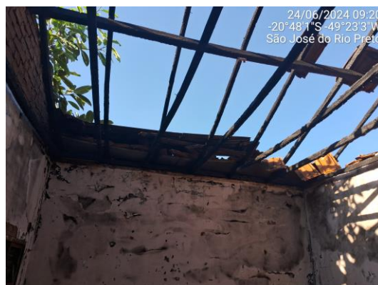
Figuras 5 e 6: Deterioração da estrutura de madeira em virtude de incêndio.
