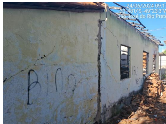
Figuras 11 e 12: Verificação da existência de trincas importantes nas alvenarias.
