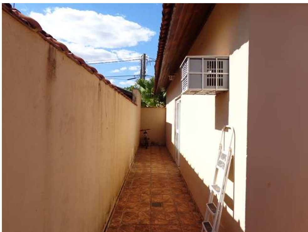
Foto13 – Detalhe do corredor lateral direito.
