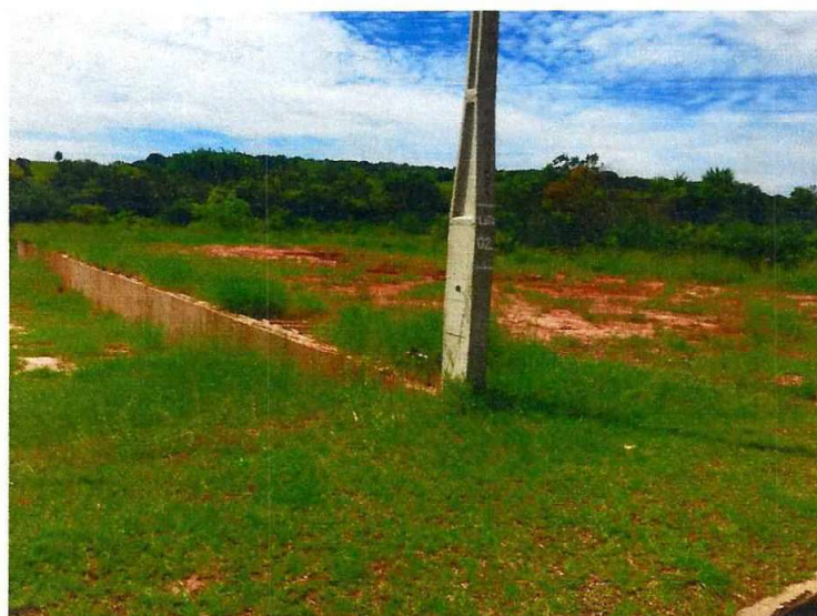
Foto nº 02 Vista do lote 02 da mesma quadra dos lotes avaliados com o muro de arrimo e o aterro necessários para o nivelamento dos lotes
