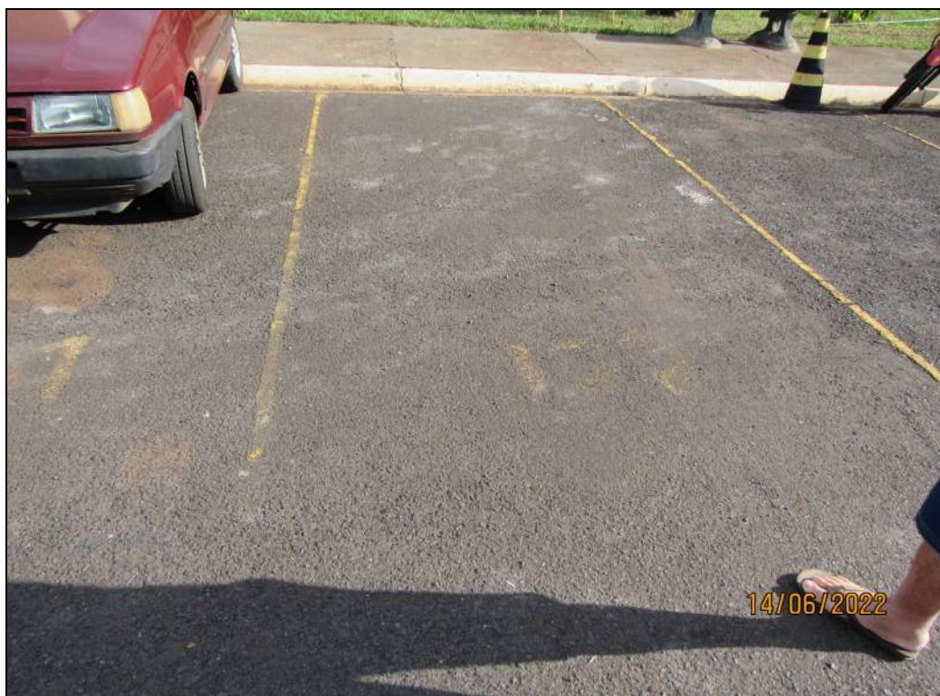
FOTO 11: Vaga de garagem descoberta da unidade avalianda.
