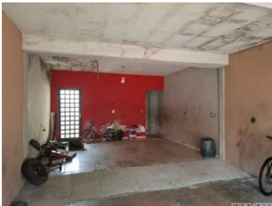
Foto 4 - Vista parcial da garagem e sala do imóvel
