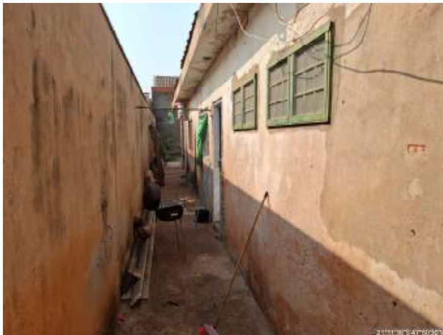
Foto 5 - Vista do corredor lateral
