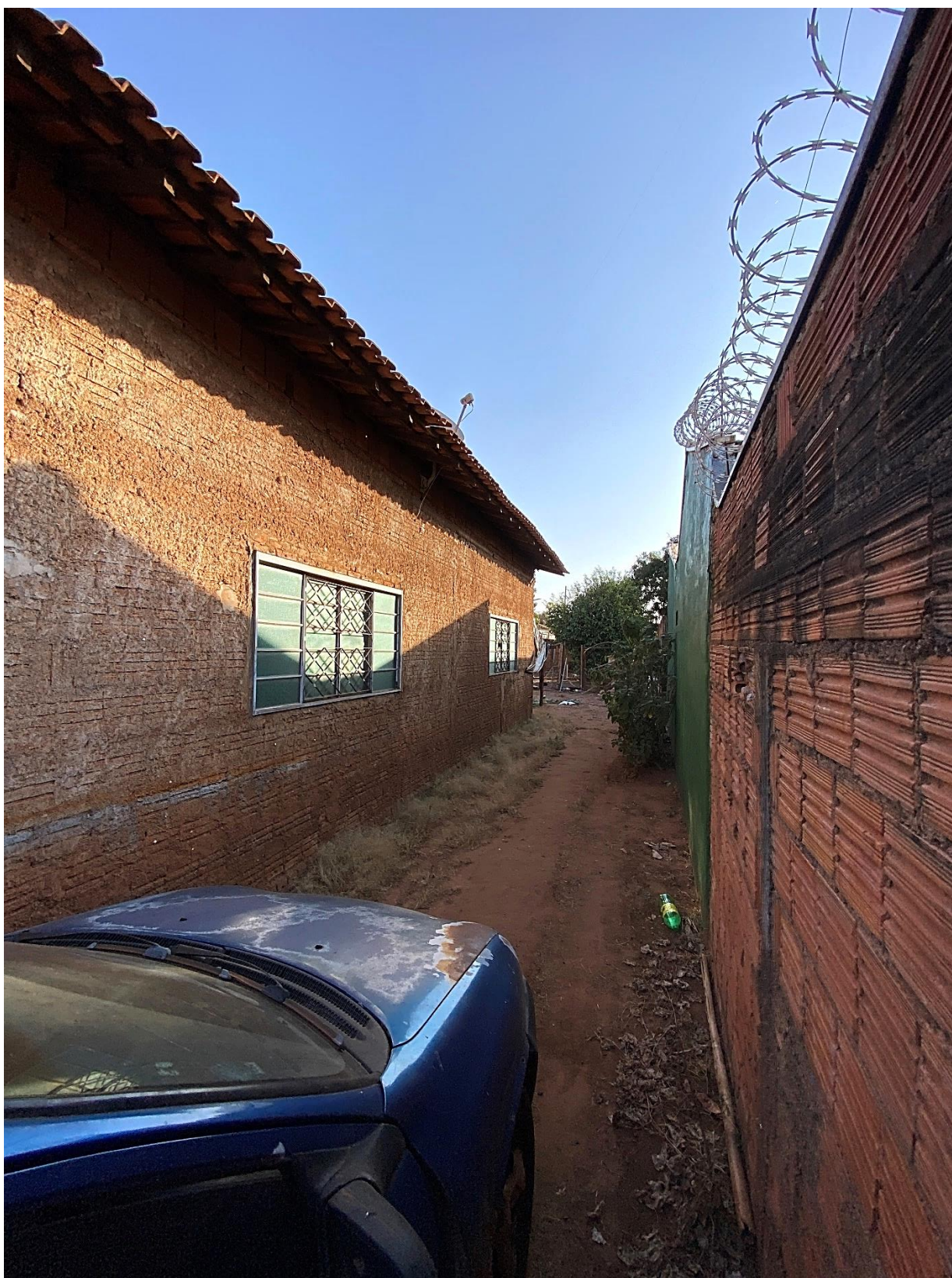
VISTA GERAL DO CORREDOR LATERAL DIREITO.
