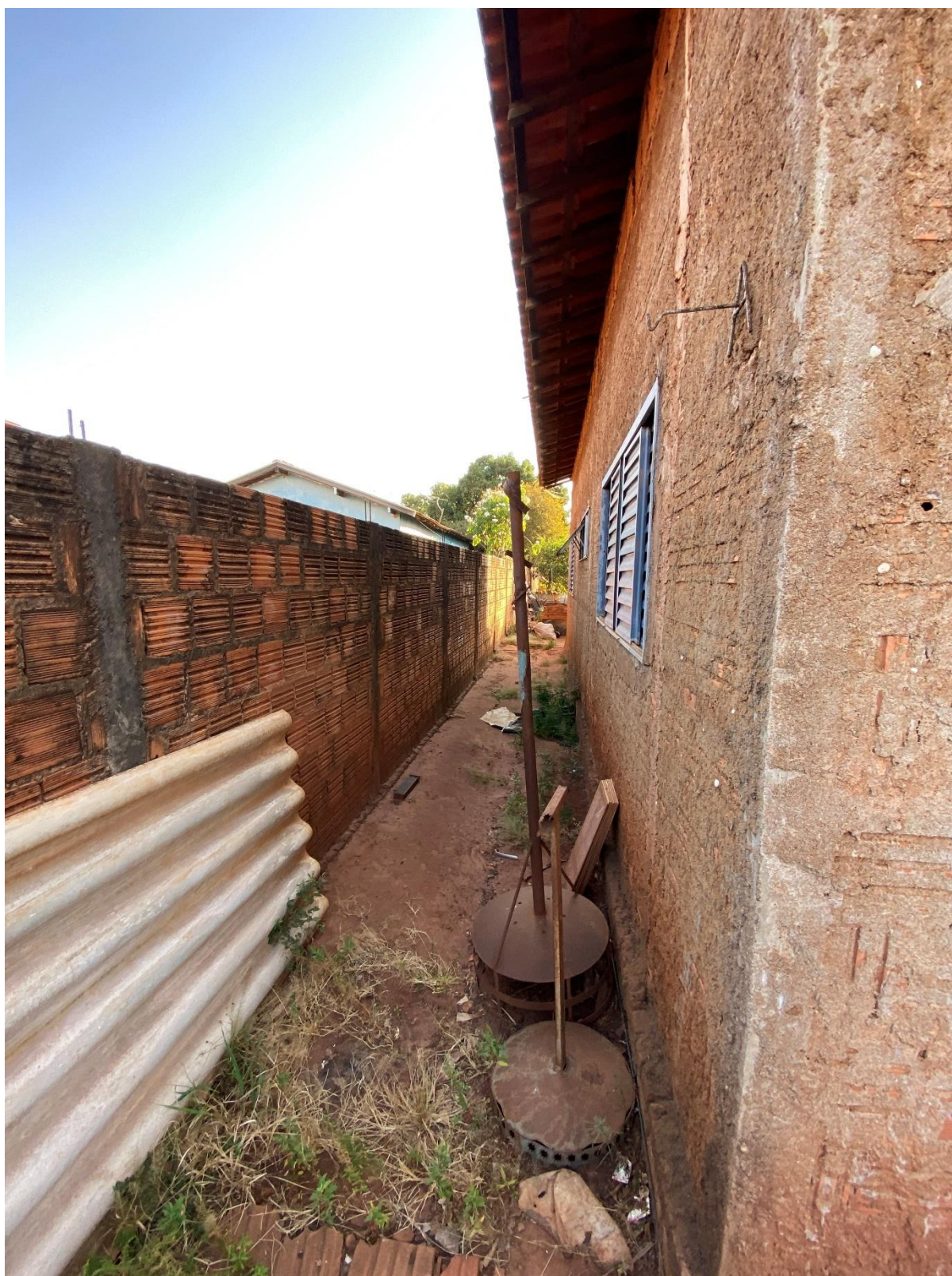
VISTA GERAL DO CORREDOR LATERAL ESQUERDO DA RESIDÊNCIA.
