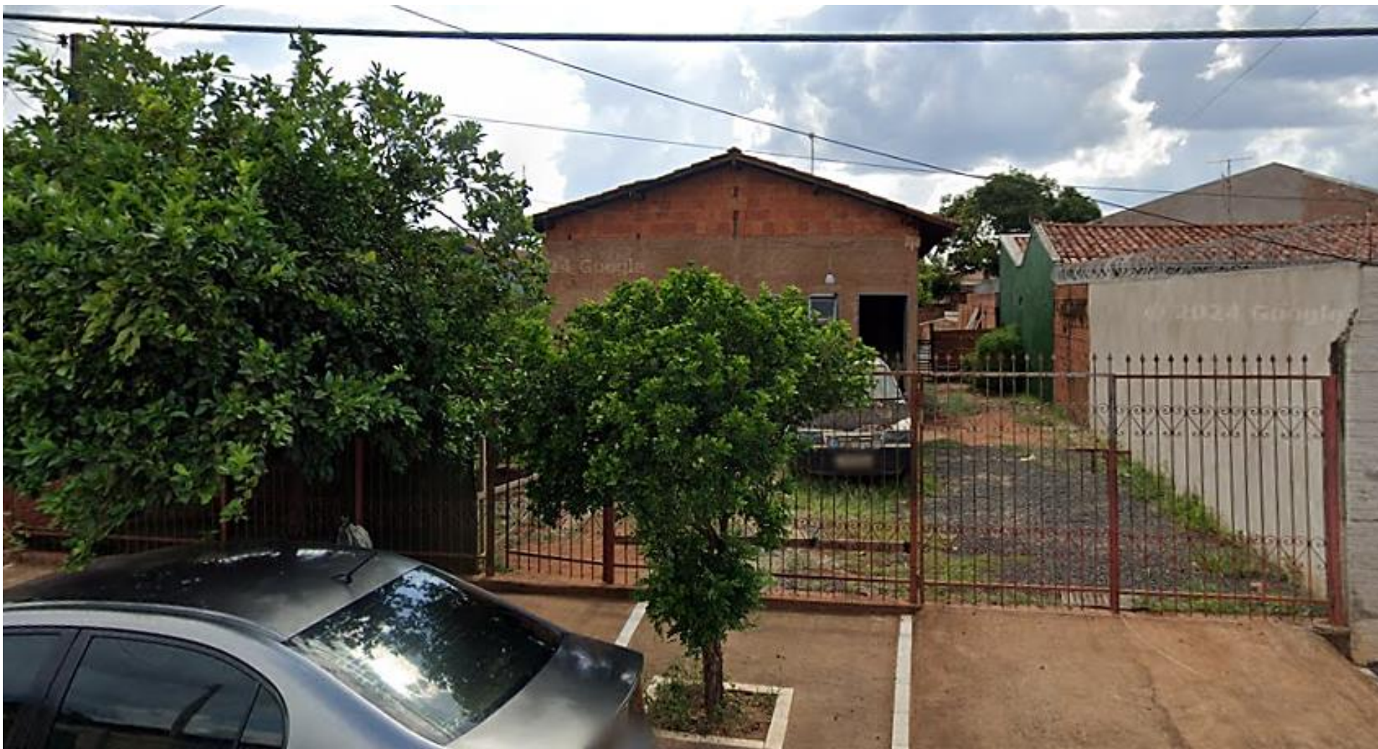
VISTA GERAL DA FACHADA DO IMÓVEL AVALIANDO PELA RUA CURITIBA.
