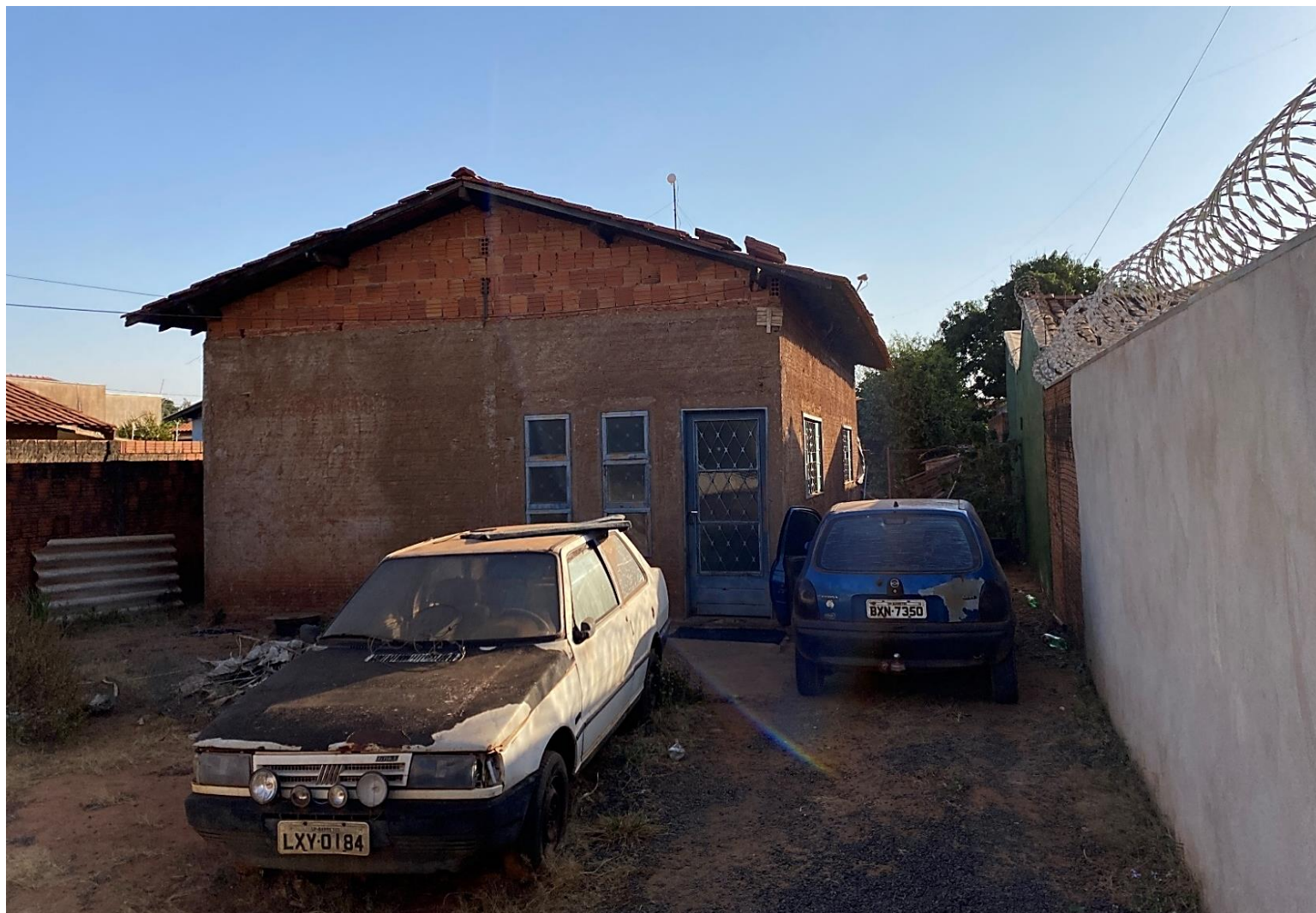
VISTA GERAL DO CORPO PRINCIPAL DA CONSTRUÇÃO EXISTENTE NO IMÓVEL.
