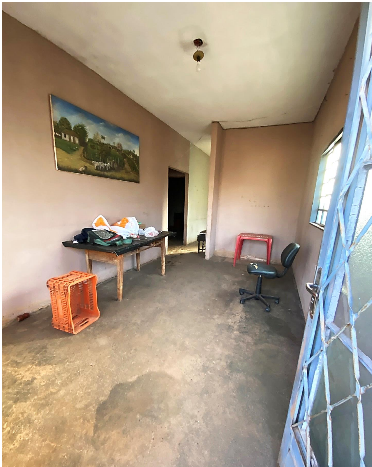
VISTA GERAL DA SALA. NOTA-SE A LAJE E AS ESQUADRIAS (PORTA E JANELA) EM FERRO E VIDRO.
