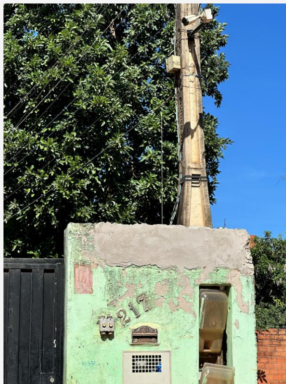
Foto 10 – Detalhe do imóvel avaliado: numeração, medidores de energia e câmera de monitoramento.
