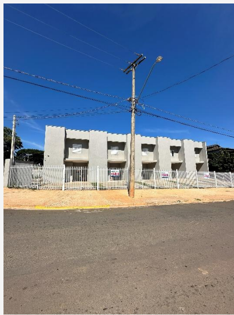
Foto 04 – Vista, na mesma rua, de sobrados recentemente construídos
