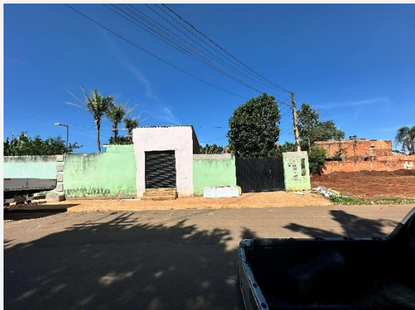
Foto 01 – Fachada principal / acesso ao imóvel
