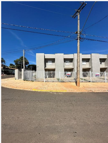
Foto 05 – Vista sobrado, esquina com o terreno limpo na lateral do imóvel avaliado
