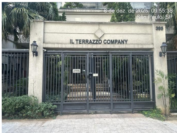
Imagem 5.1.1: Entrada do edifício IL TERRAZZO COMPANY;
